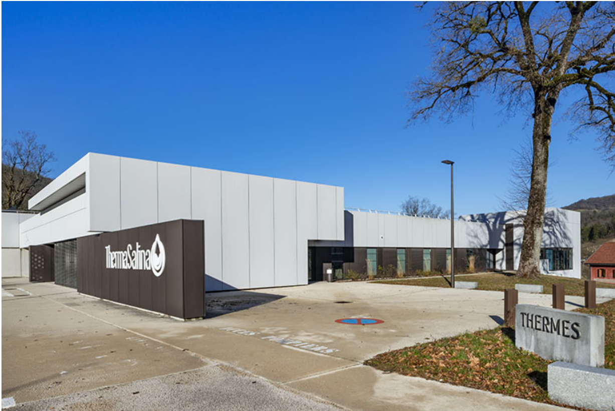
Vue depuis le sud-est.
