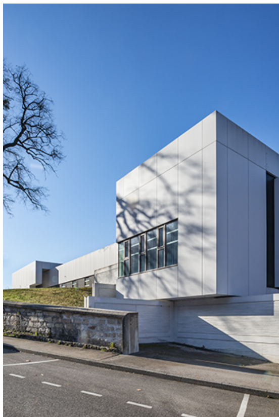
Vue depuis le nord-est.
