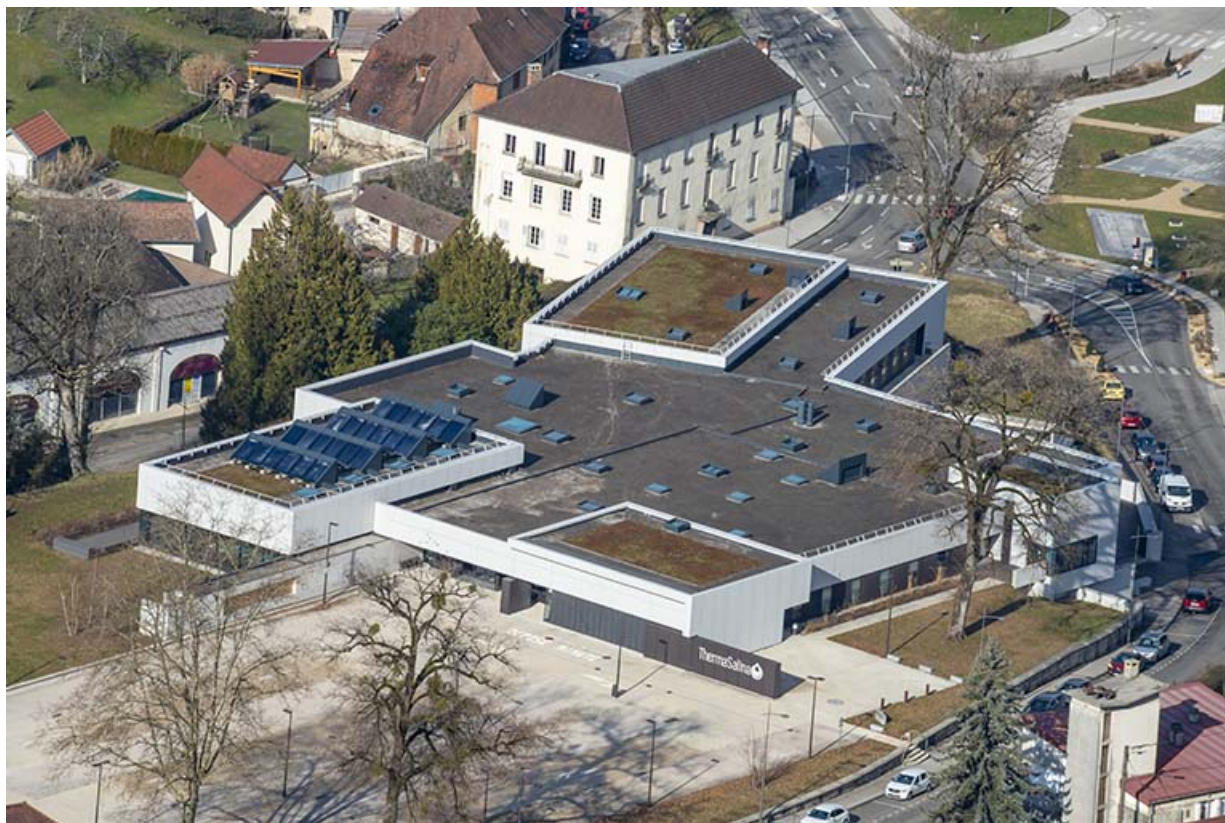
Vue depuis le mont Saint-André. 39, Salins-les-Bains place Barbarine
