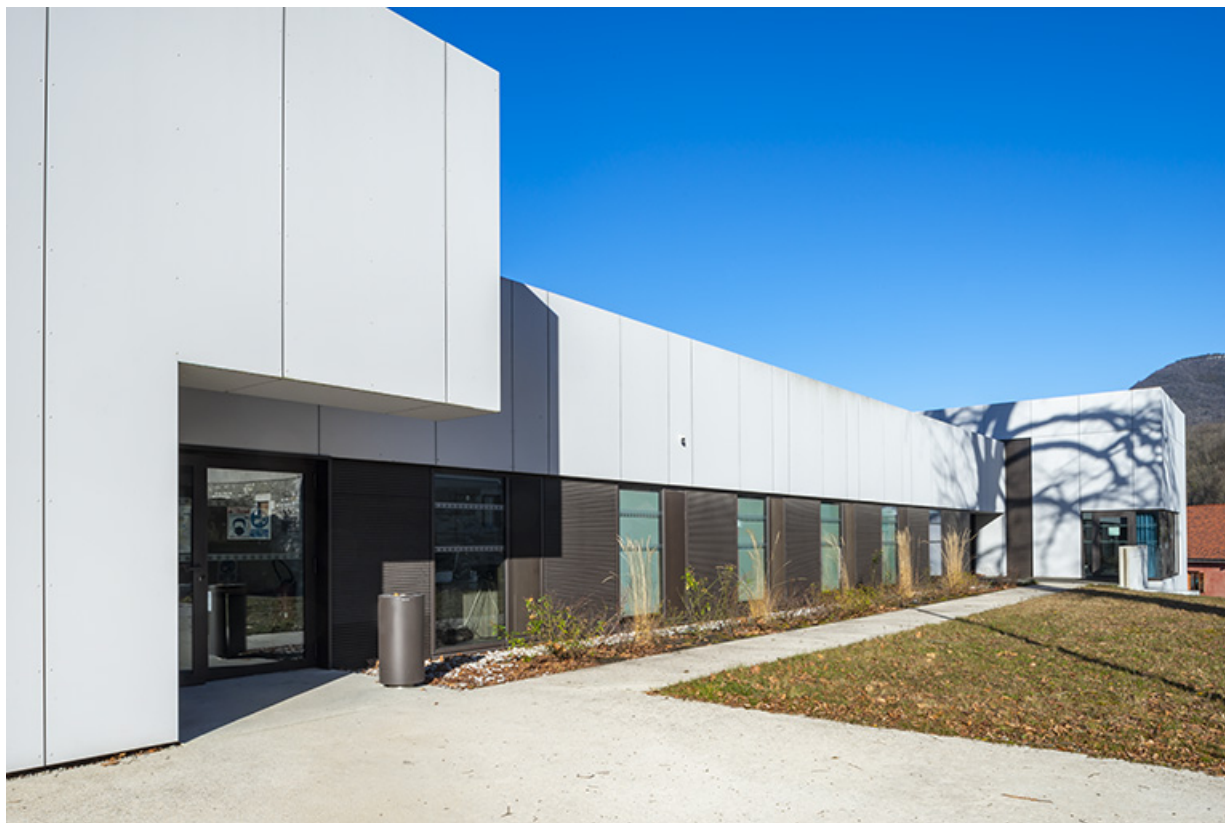
Vue depuis le sud-est.
