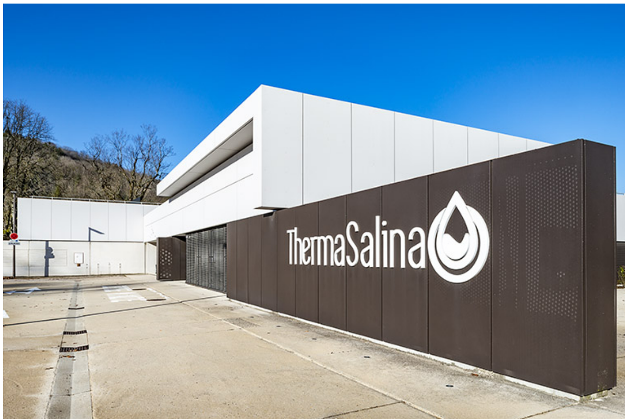
Façade sud, accès principal des curistes, depuis l'est. 39, Salins-les-Bains place Barbarine
