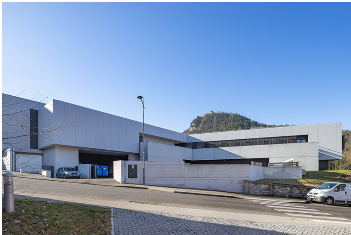
Façade postérieure, entrée des équipements techniques sur la rampe Barbarine. 39, Salins-les-Bains place Barbarine
