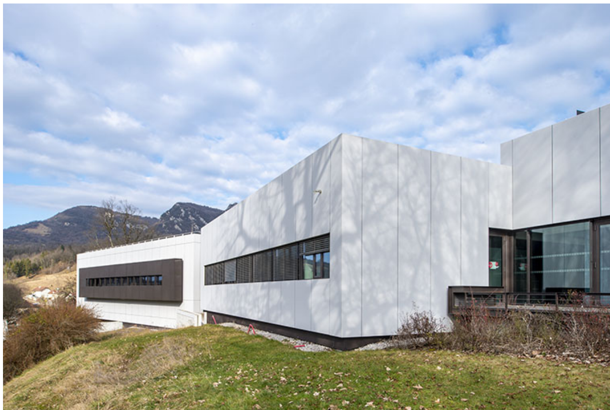
Vue depuis le sud-ouest.
