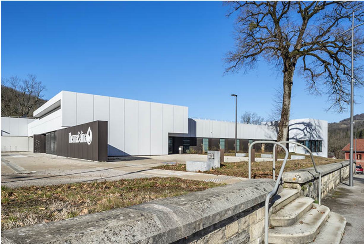
Vue depuis le sud-est.
