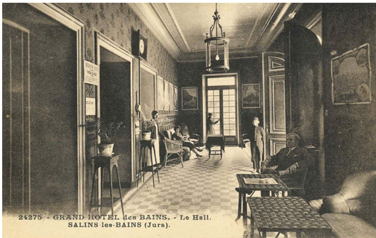
Vue ancienne du hall d'entrée, en direction du nord.
