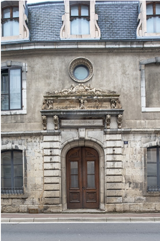
Façade est, portail d'entrée.
