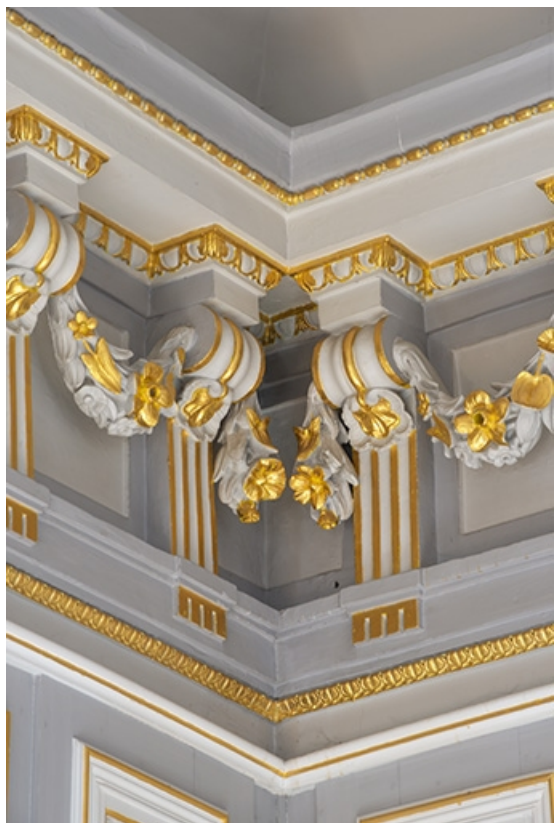
Salle de restaurant, triglyphes à enroulement formant modillon, ornés de guirlandes végétales. 39, Salins-les-Bains, 2 place des Alliés et de la Résistance
