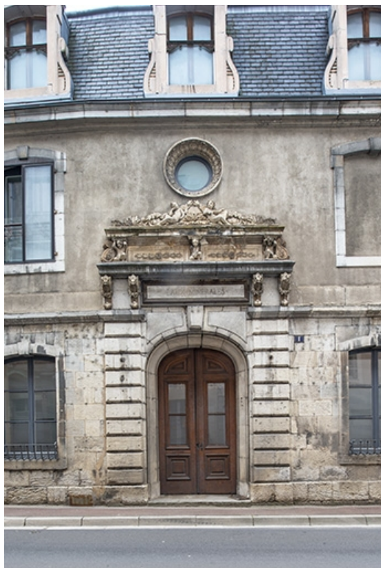
Façade est, portail d'entrée.
