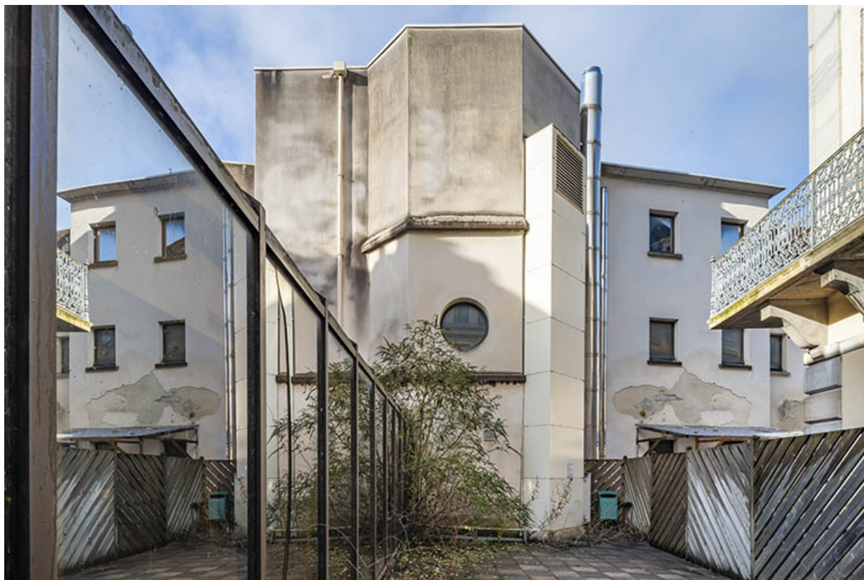
Cour, ancienne tour du réservoir et aile de la piscine (à gauche).
