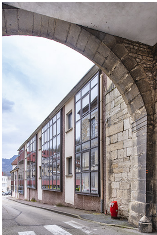
Façade sur la rue des Barres, vue à travers un passage de l'Hôtel de Ville. 39, Salins-les-Bains place des Alliés et de la Résistance
