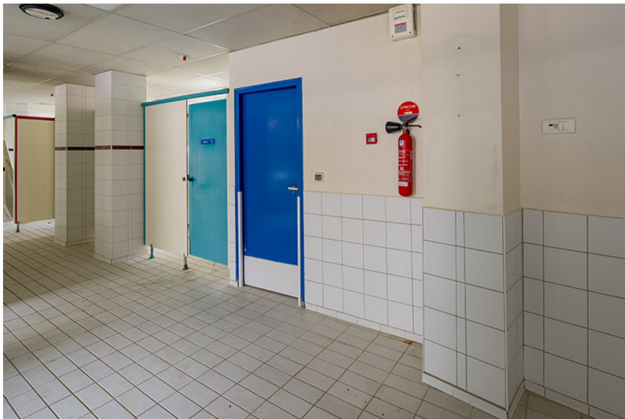
Emplacement de l'ancien escalier du hall de l'établissement thermal des années 1930.
