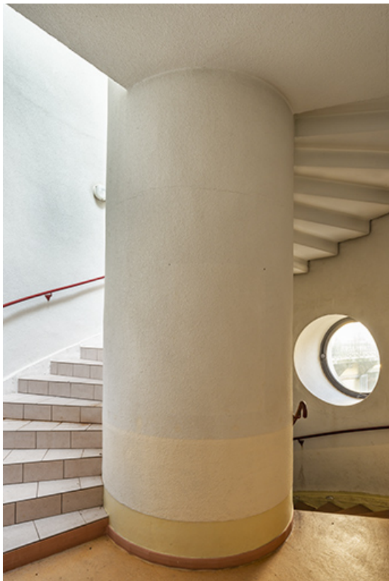
Escalier en vis créé dans l'ancienne tour du réservoir dans les années 1990, palier du premier étage. 39, Salins-les-Bains place des Alliés et de la Résistance
