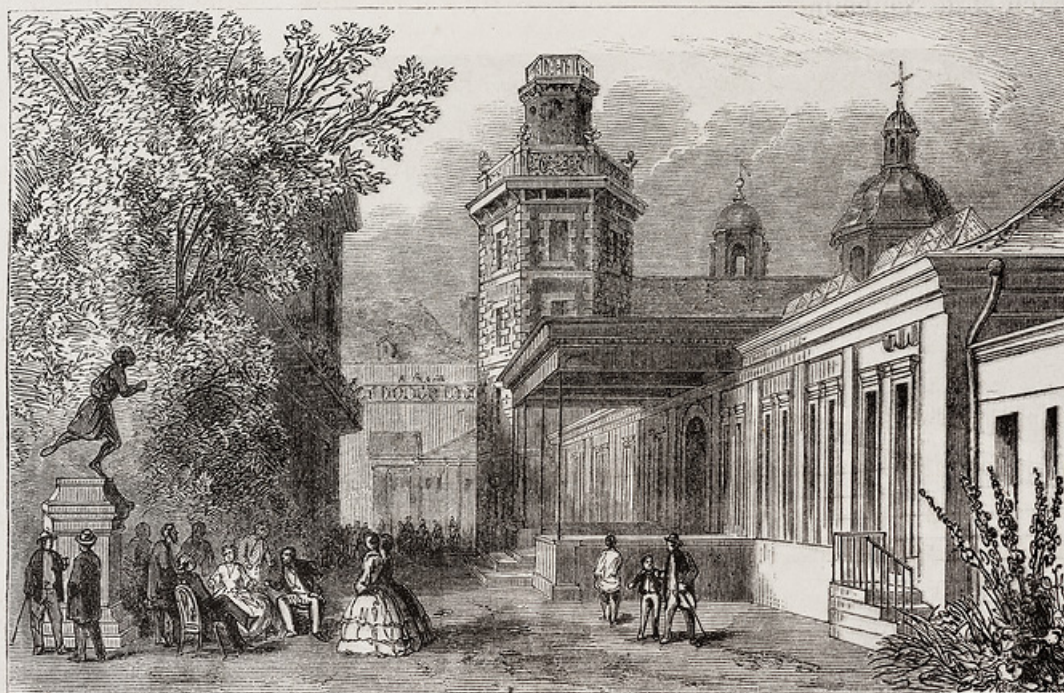
Vue du Jardin de l'Établissement.
