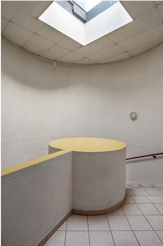
Escalier en vis créé dans l'ancienne tour du réservoir dans les années 1990, palier du second étage. 39, Salins-les-Bains place des Alliés et de la Résistance
