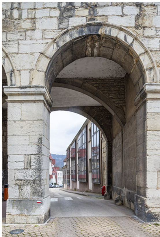
Façade sur la rue des Barres, vue à travers un passage de l'Hôtel de Ville. 39, Salins-les-Bains place des Alliés et de la Résistance
