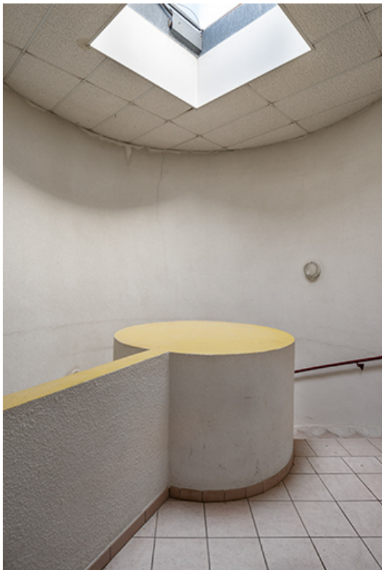
Escalier en vis créé dans l'ancienne tour du réservoir dans les années 1990, palier du second étage. 39, Salins-les-Bains place des Alliés et de la Résistance
