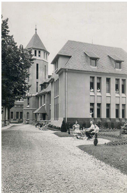
Façade sur le jardin du Grand Hôtel des Bains.
