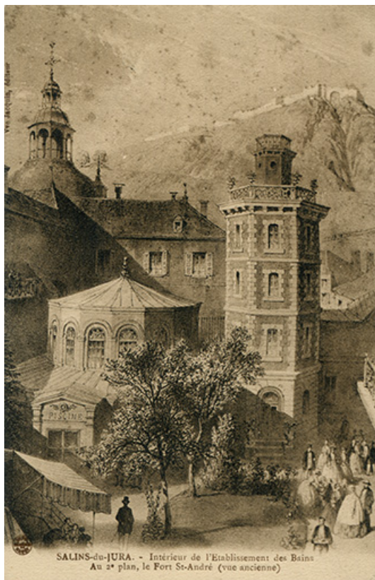
Vue de la cour (troisième quart du 19e siècle).
