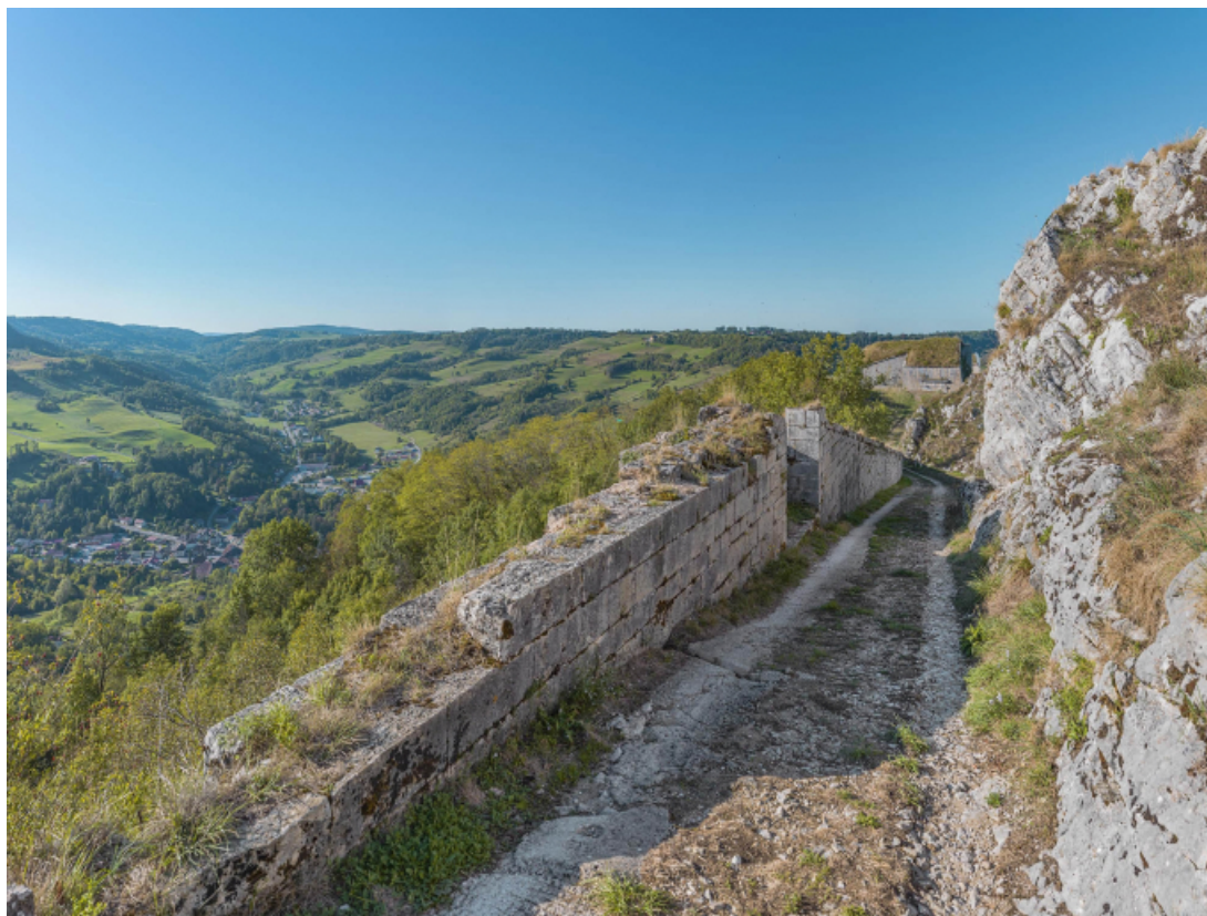
Chemin couvert reliant la redoute de Grelimbach à l'enceinte principale du fort.
