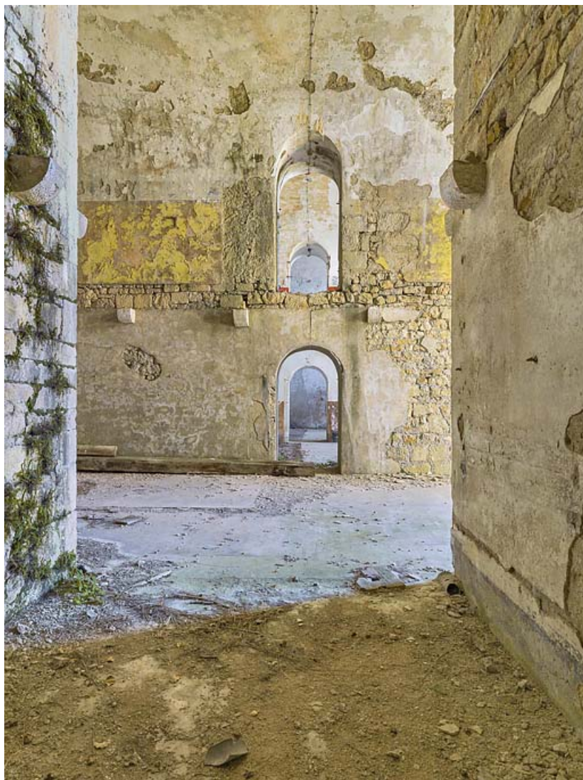
Vue intérieure du bâtiment casematé : les corbeaux attestent l'existence d'un plancher disparu.
