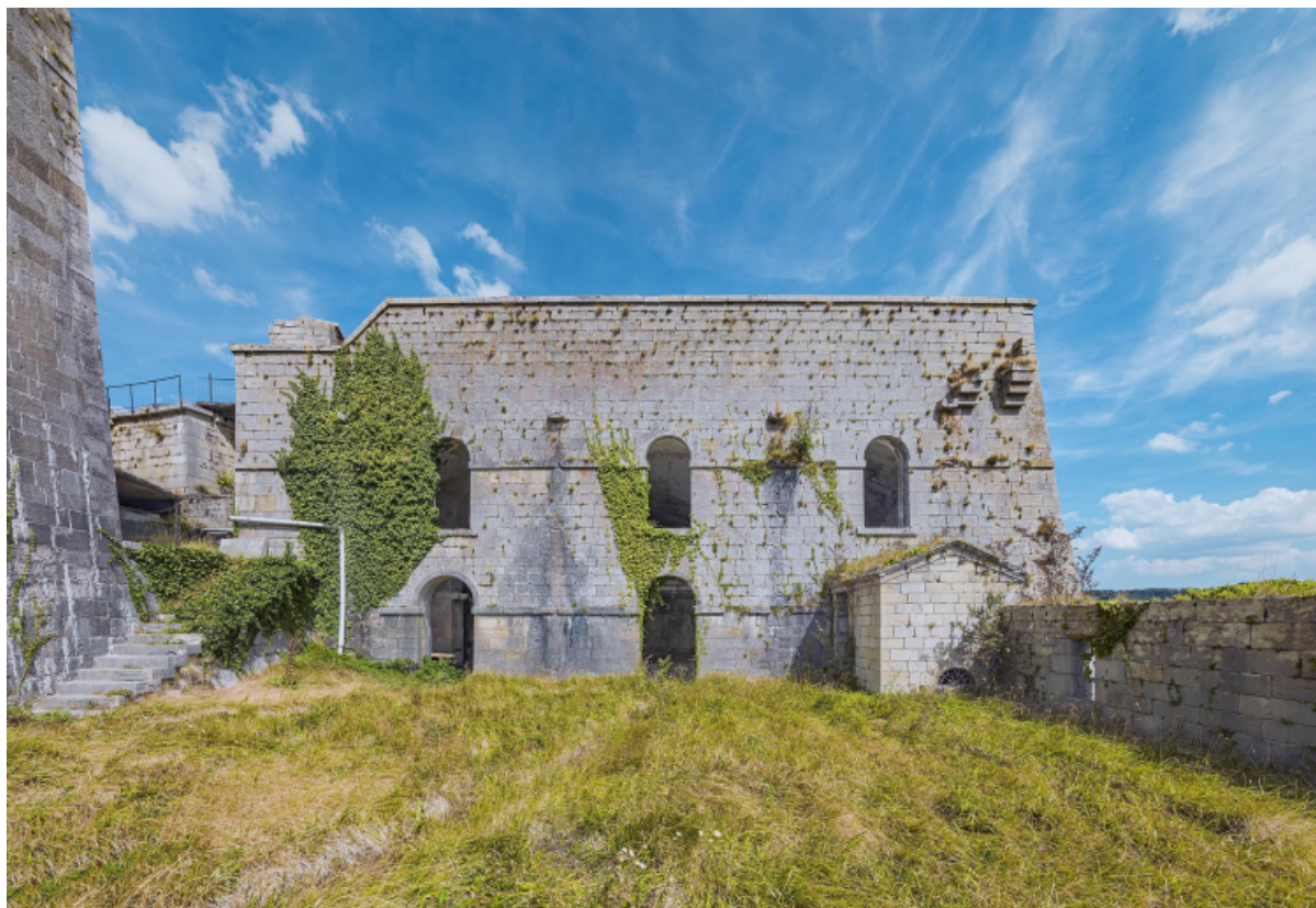
Bâtiment casematé servant à accueillir une garnison et des magasins.
