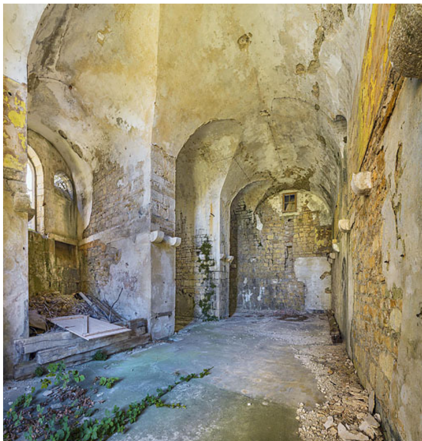
Vue intérieure du bâtiment casematé.
