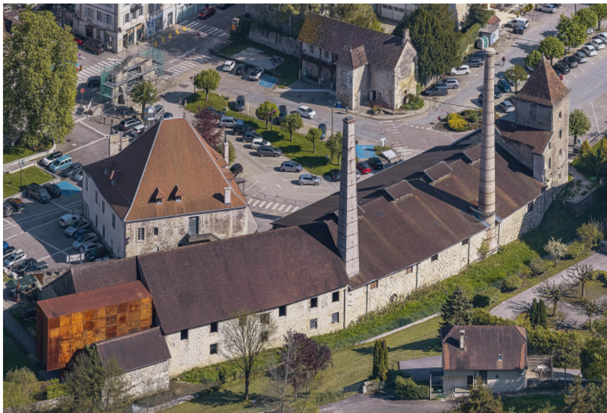
Bourg : la saline depuis le fort Saint-André. 39, Salins-les-Bains
