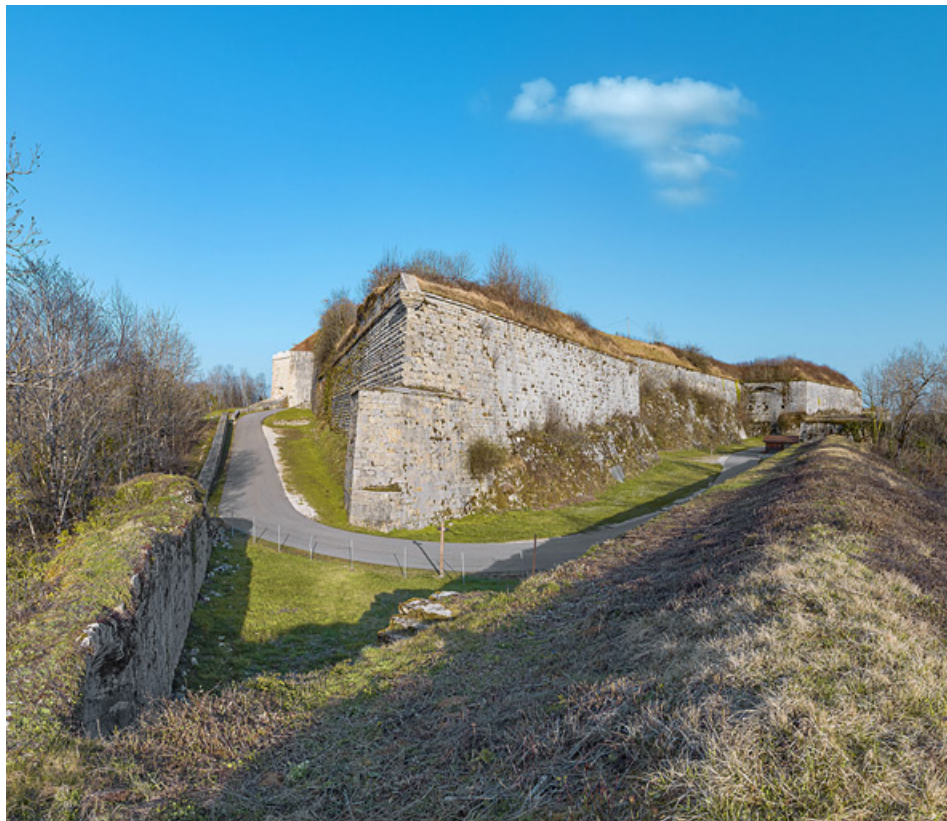
Fort Saint-André : angle nord-ouest et son demi-bastion.
