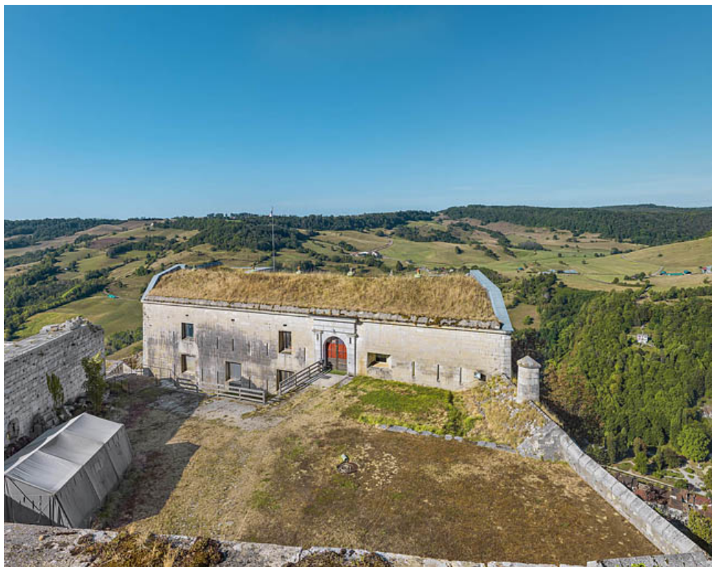
Fort Belin : le réduit.
