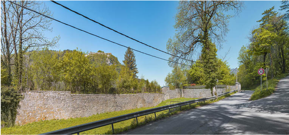
Bourg : mur de l'ancienne enceinte fortifiée. 39, Salins-les-Bains
