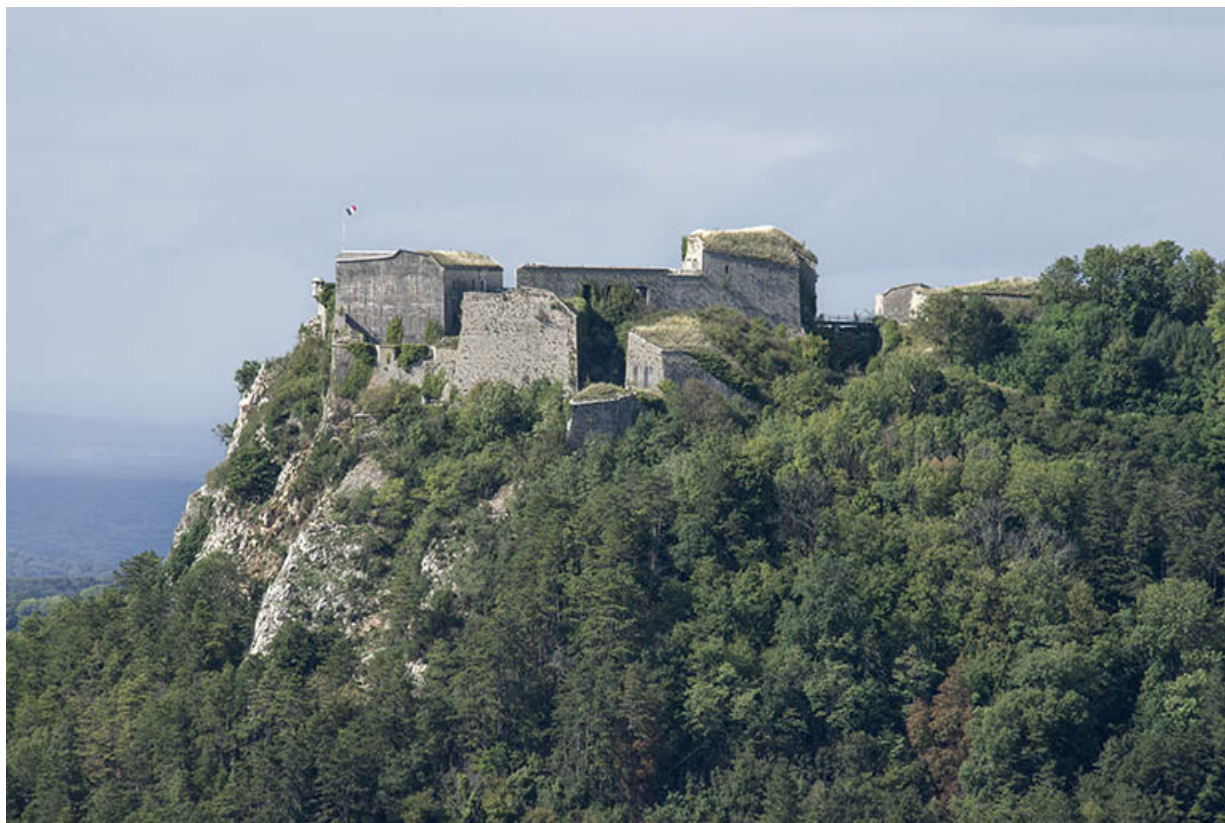
Fort Belin : vue générale du front sud.
