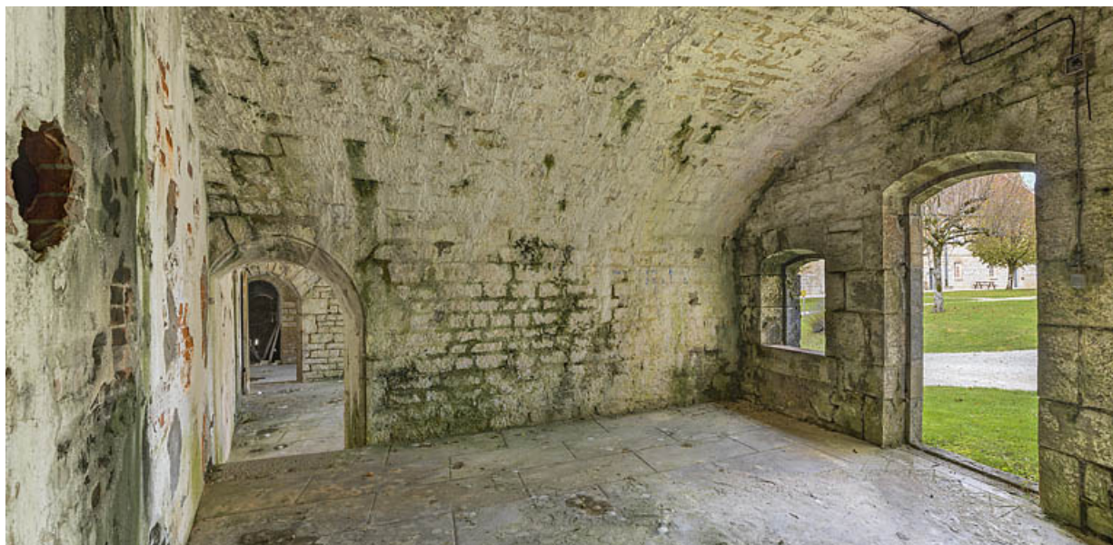
Fort Saint-André : pièce casematée.
