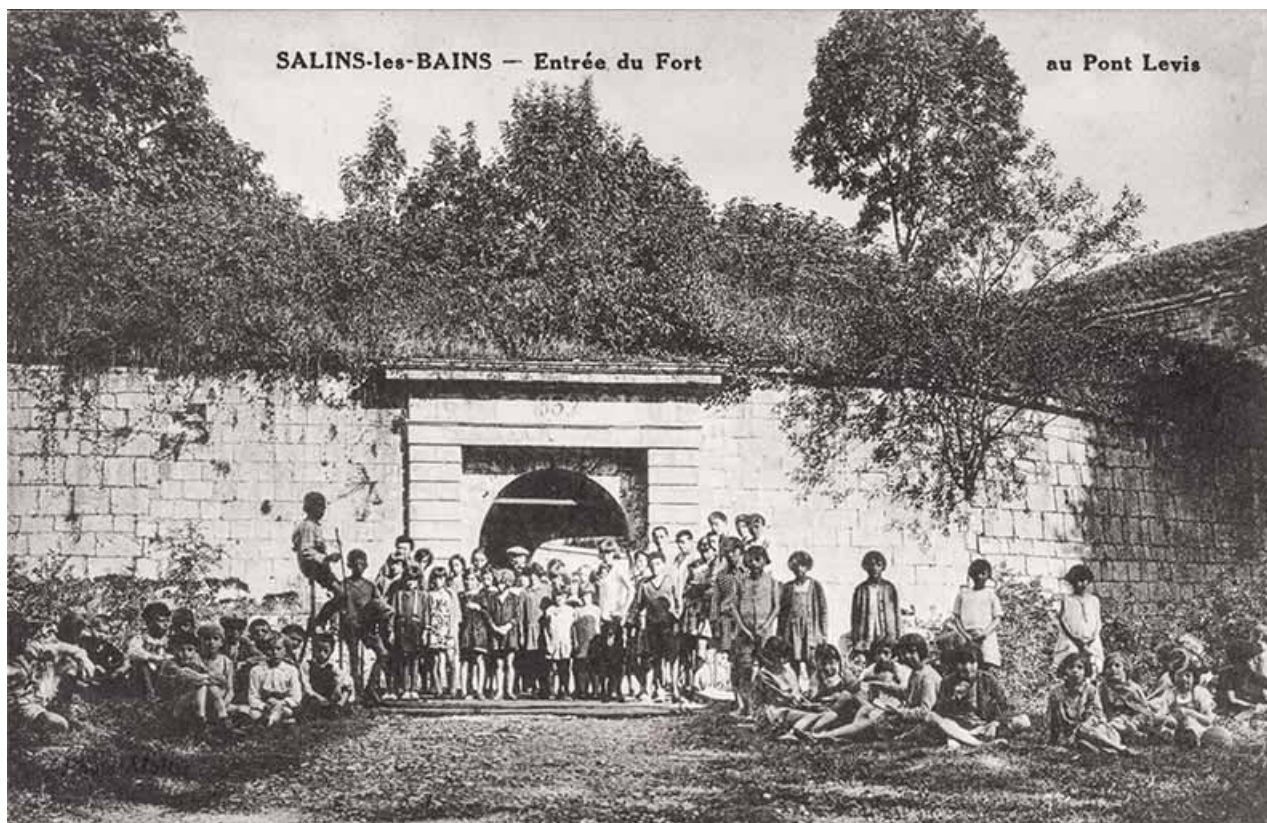
Salins-les-Bains (Jura). Entrée du fort au pont levis. S.d.
