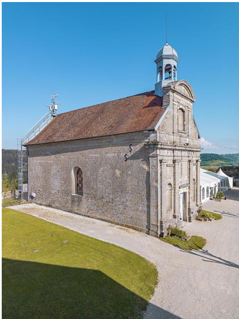
Cantine et logement du gardien de batterie : façade antérieure.
