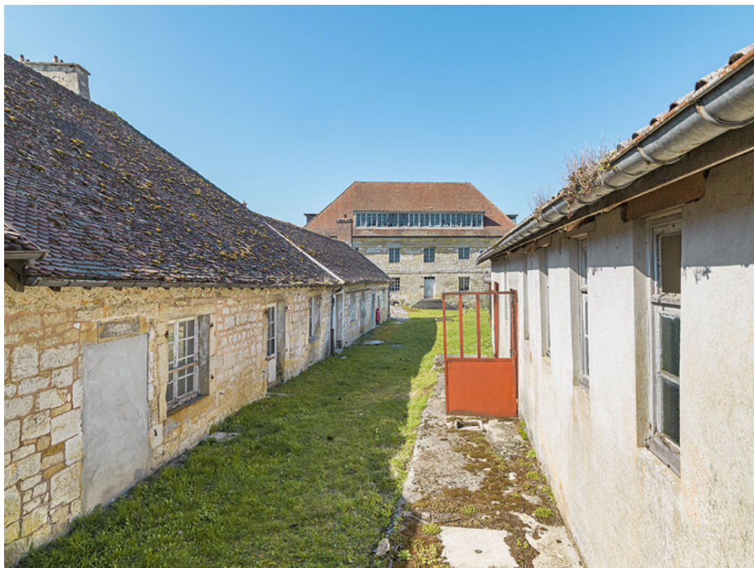
Cantine et logement du gardien de batterie : façade postérieure. Logement du gouverneur en arrière-plan. 39, Salins-les-Bains chemin du Fort Saint-André, lieudit : Fort Saint-André
