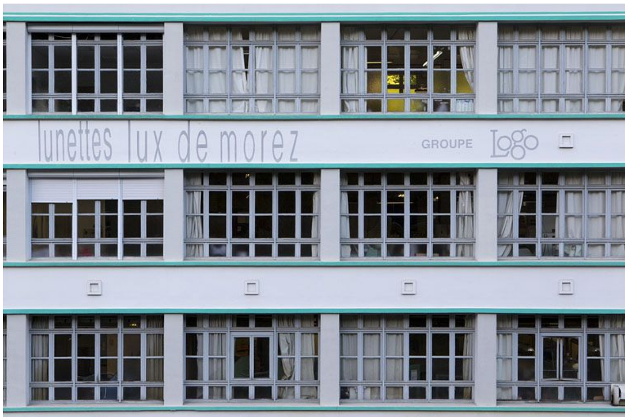
Usine d'horlogerie Odo puis de lunetterie Lux de Morez, actuellement Logo : baies des ateliers.
