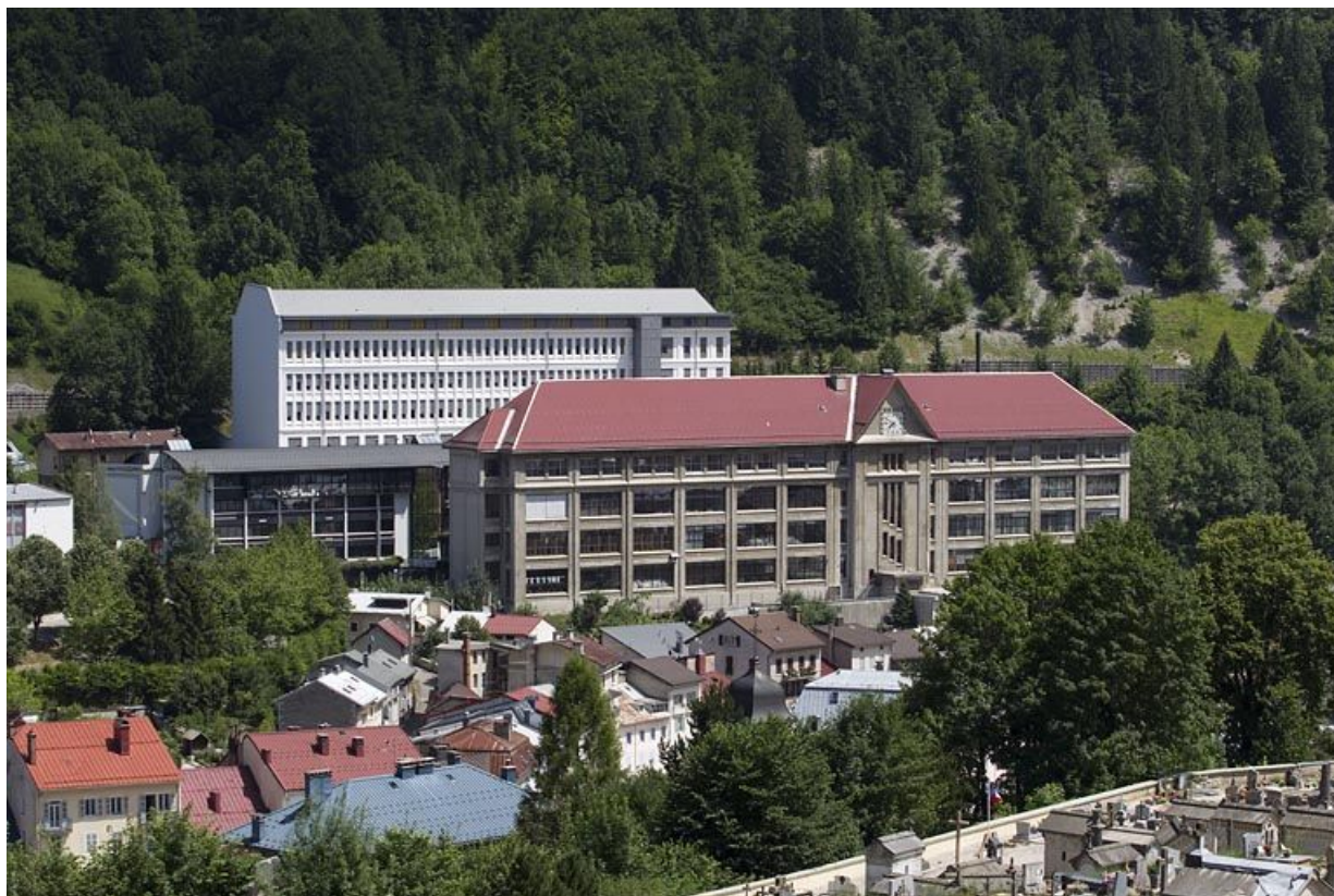
Vue d'ensemble, depuis l'ouest. A l'arrière, le bâtiment D après restauration.
