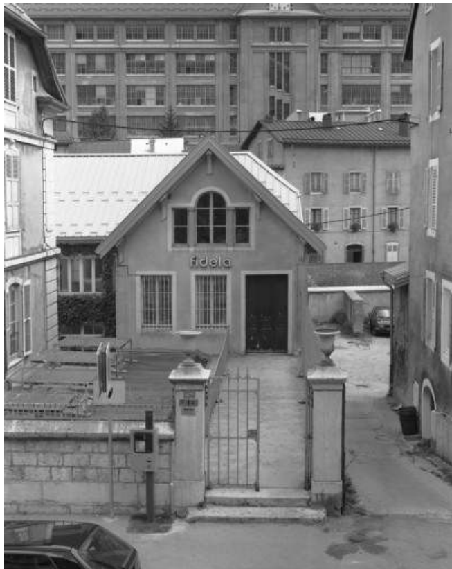
Façade antérieure de l'usine.
