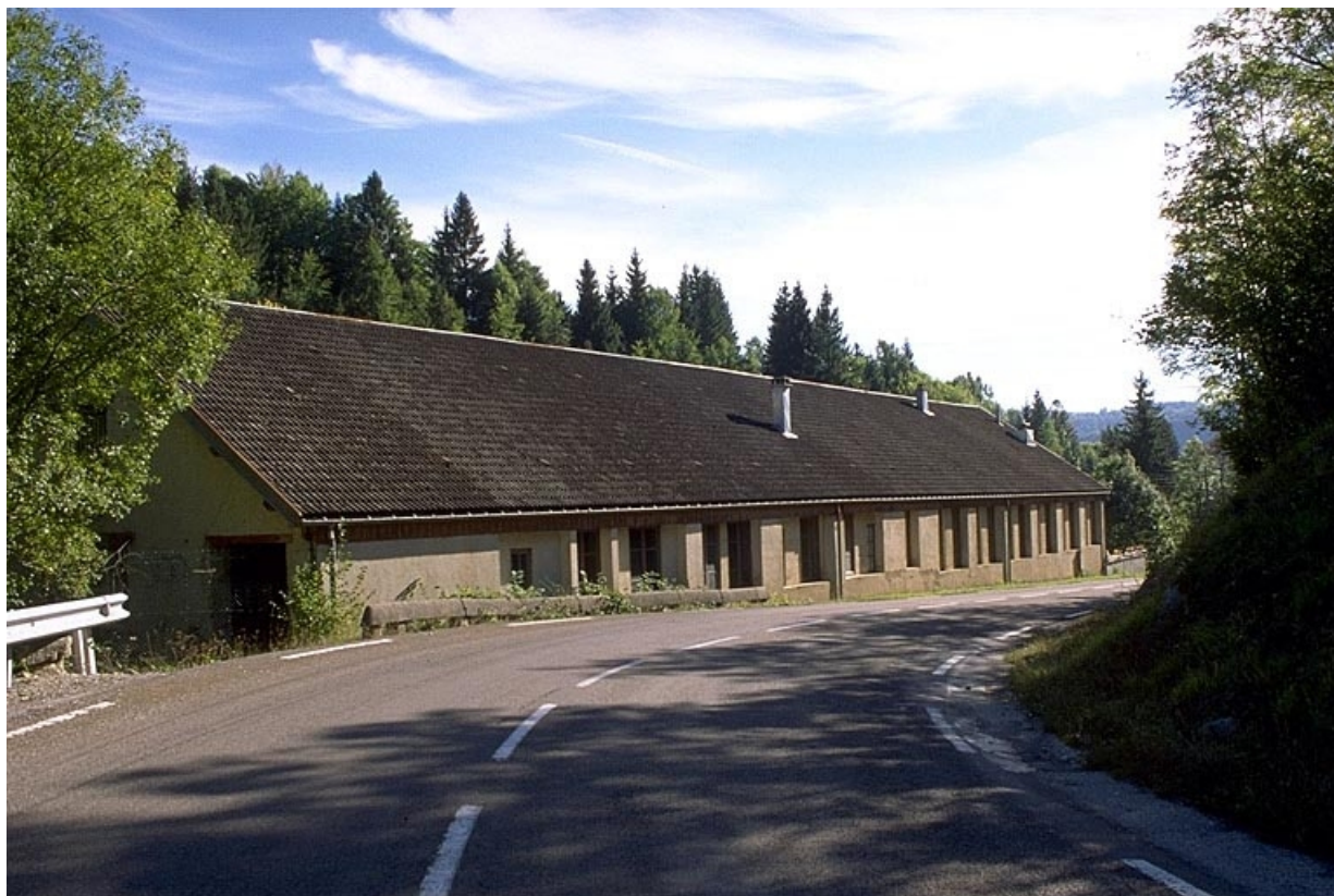
Façade ouest de l'atelier de fabrication.
