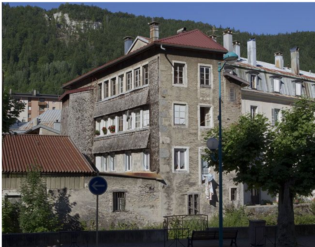
Façades postérieure et latérale droite.
