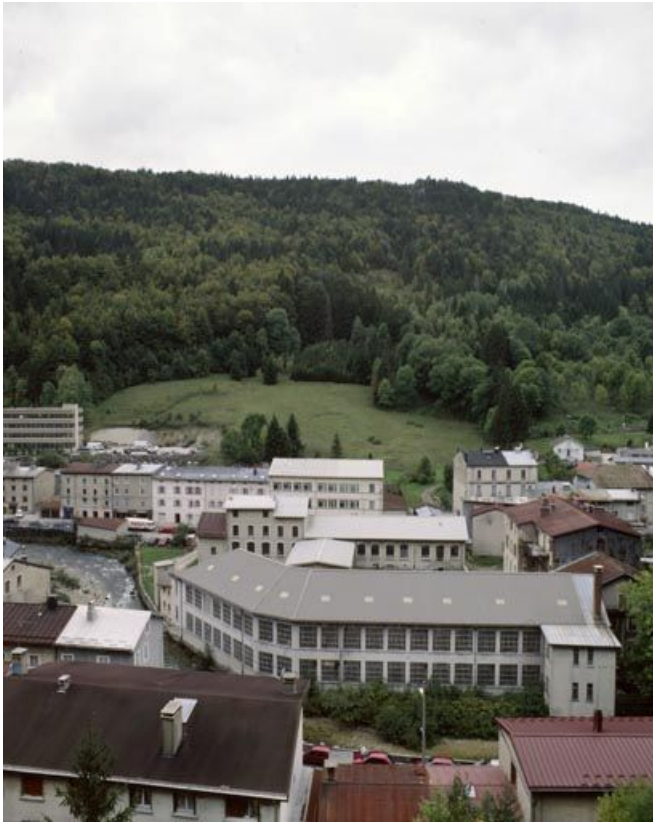
Usine de la Manufacture mécanique de Lunetterie et d'Optique (199 rue de la République), avant sa destruction. À l'arrière-plan, au centre l'ancienne usine de la Société des Lunetiers (194 à 198 rue de la République) et à gauche l'extrémité d'un bâtiment de la société lunetière L'Amy (216 à 220 de la même rue).
