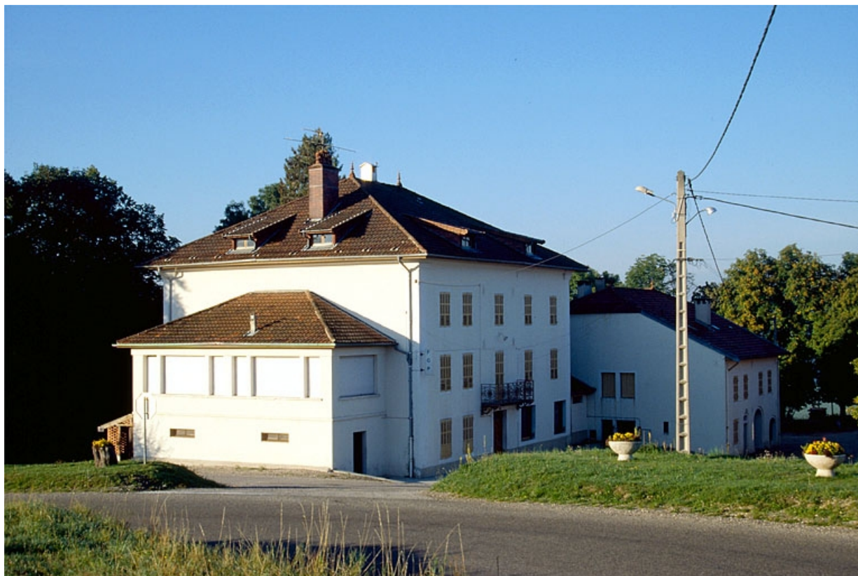
Vue générale du logement patronal et de l'ancienne lunetterie.
