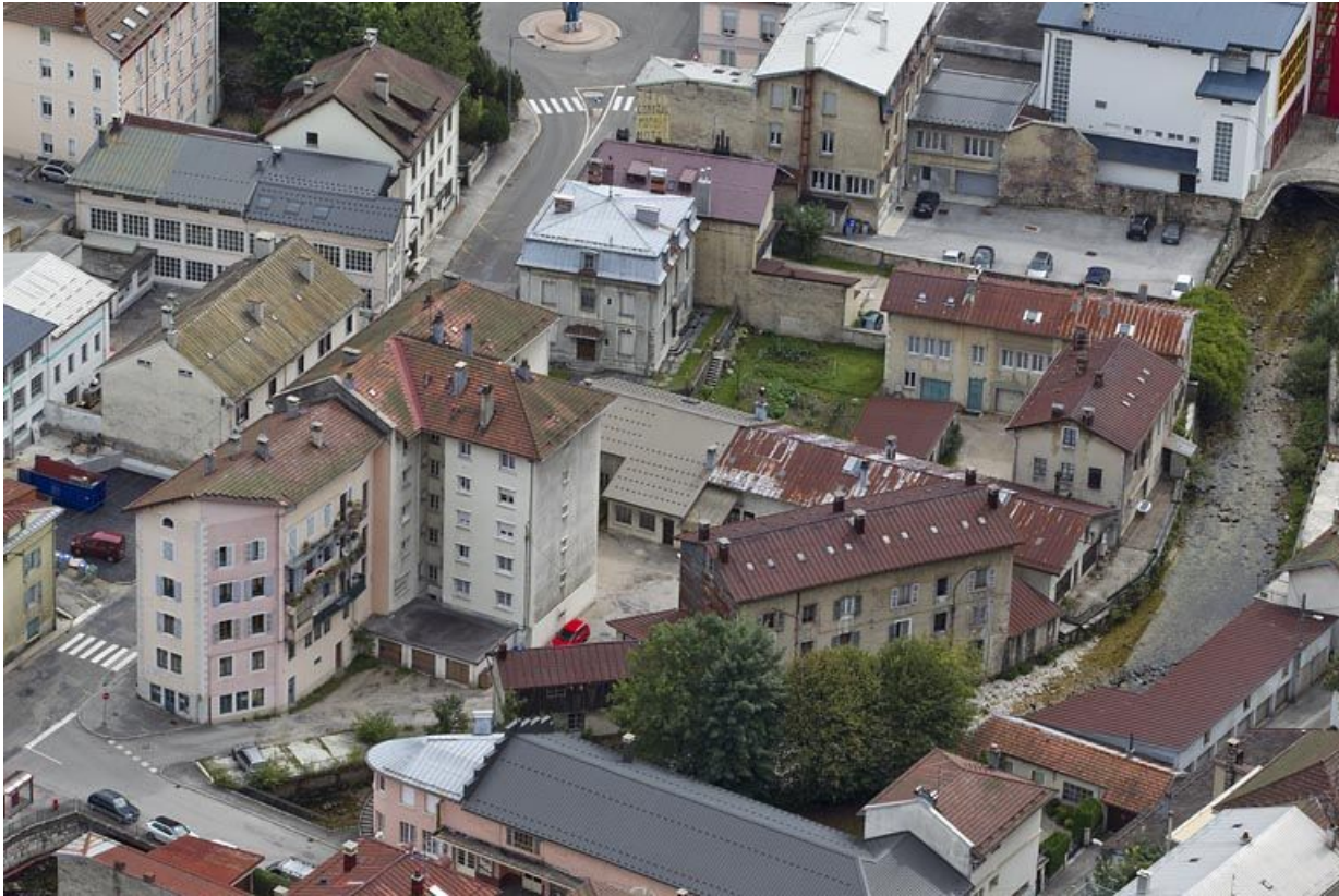
Vue d'ensemble plongeante, depuis le nord.
