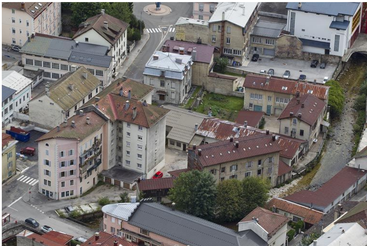
Vue d'ensemble plongeante, depuis le nord.
