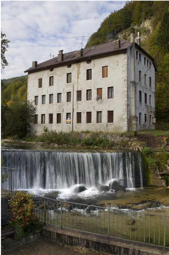
Ancienne usine d'horlogerie Emmanuel Girod puis de matériel d'équipement industriel Benier-Rollet (18 rue Pierre Morel).
