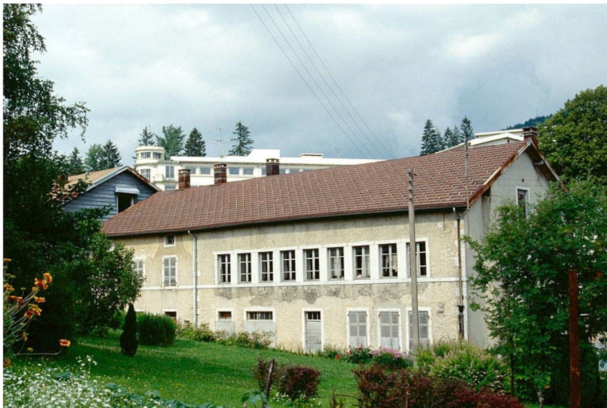
Vue d'ensemble de la façade postérieure.
