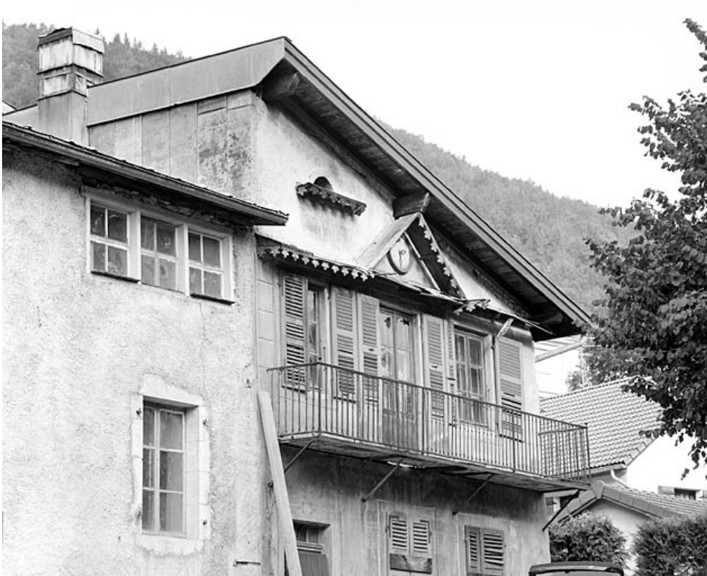
Etage du corps de bâtiment nord.
