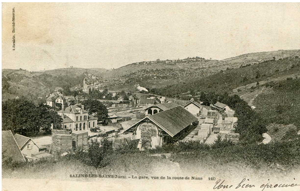
Salins-les-Bains (Jura) - La gare, vue depuis la route de Nans, s.d. [fin 19e ou début 20e siècle].
