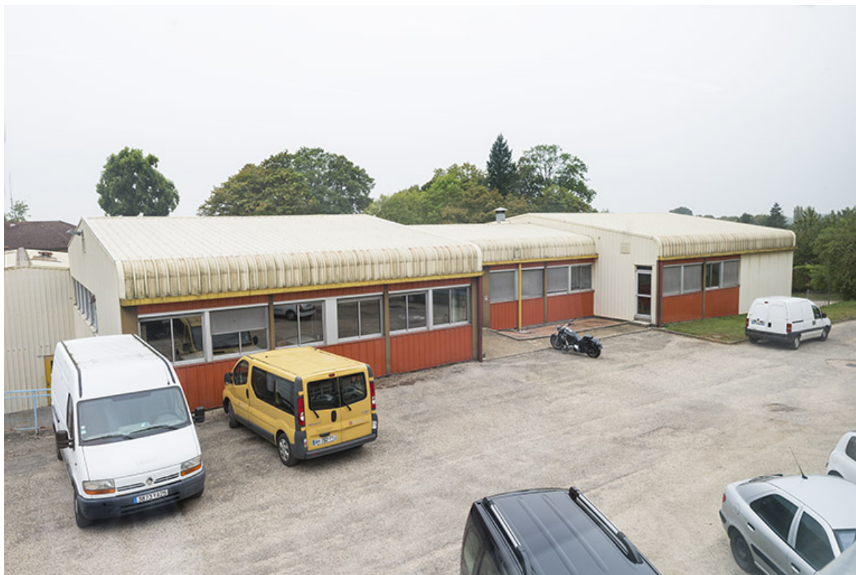
Vue des ateliers depuis l'externat
