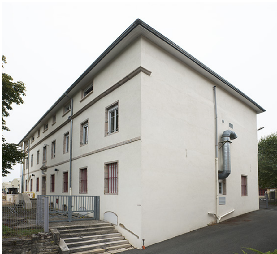
Internat : façades ouest sur rue Lamartine et pignon sud.
