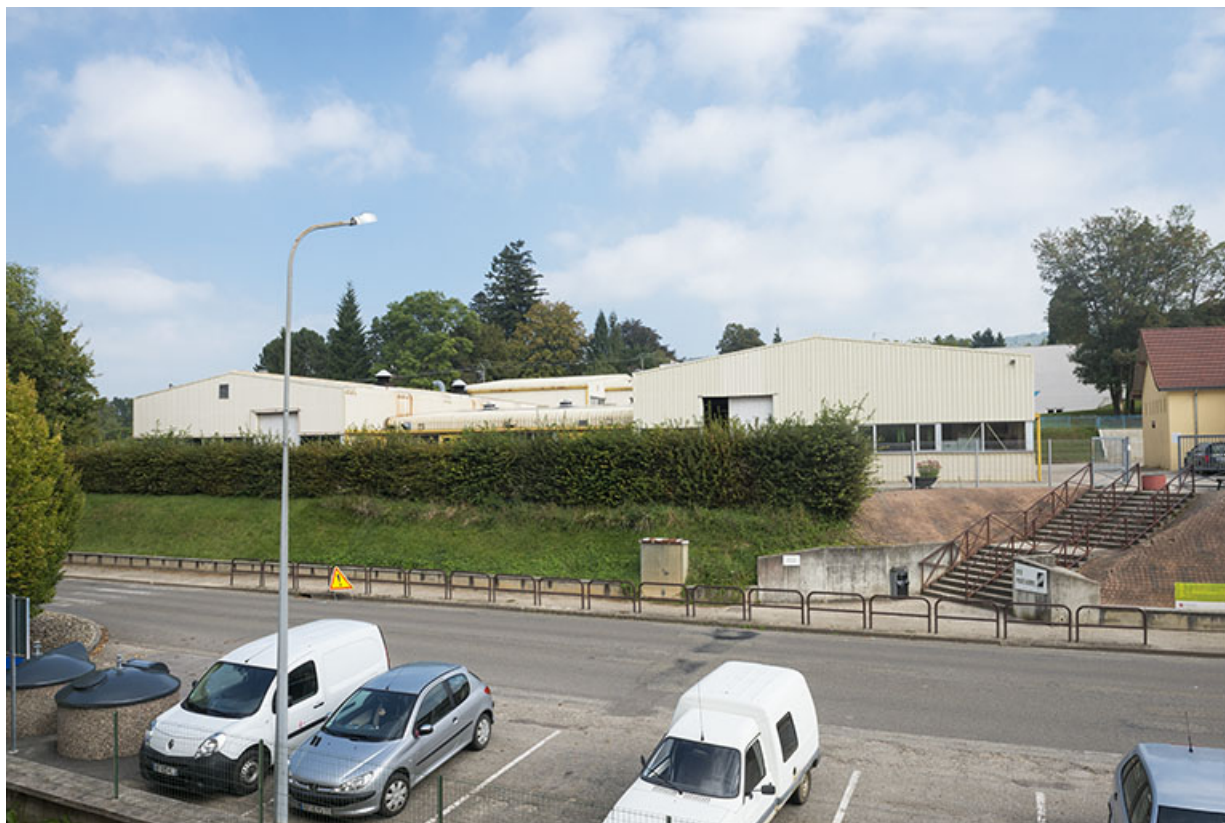
Vue générale des ateliers depuis la rue Lamartine.
