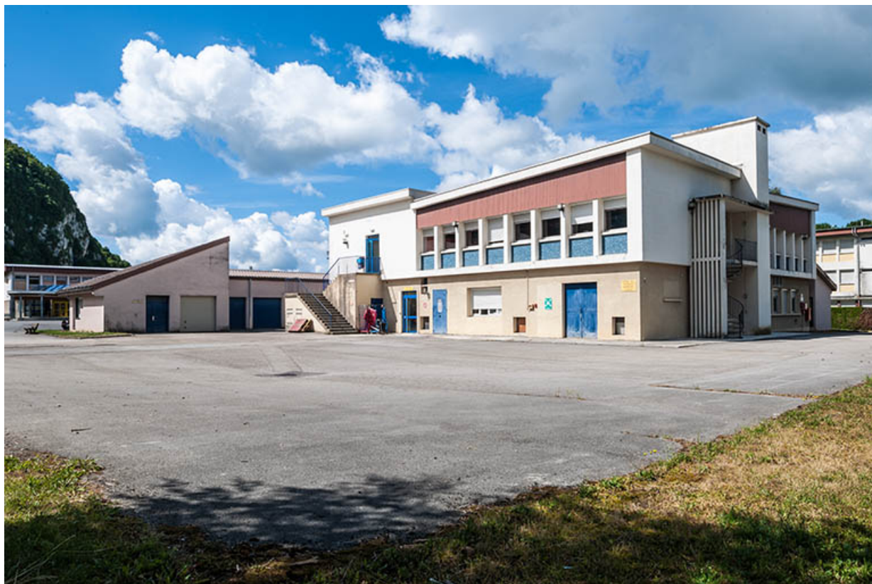
Restauration, bâtiment initial, vue de trois quart arrière.
