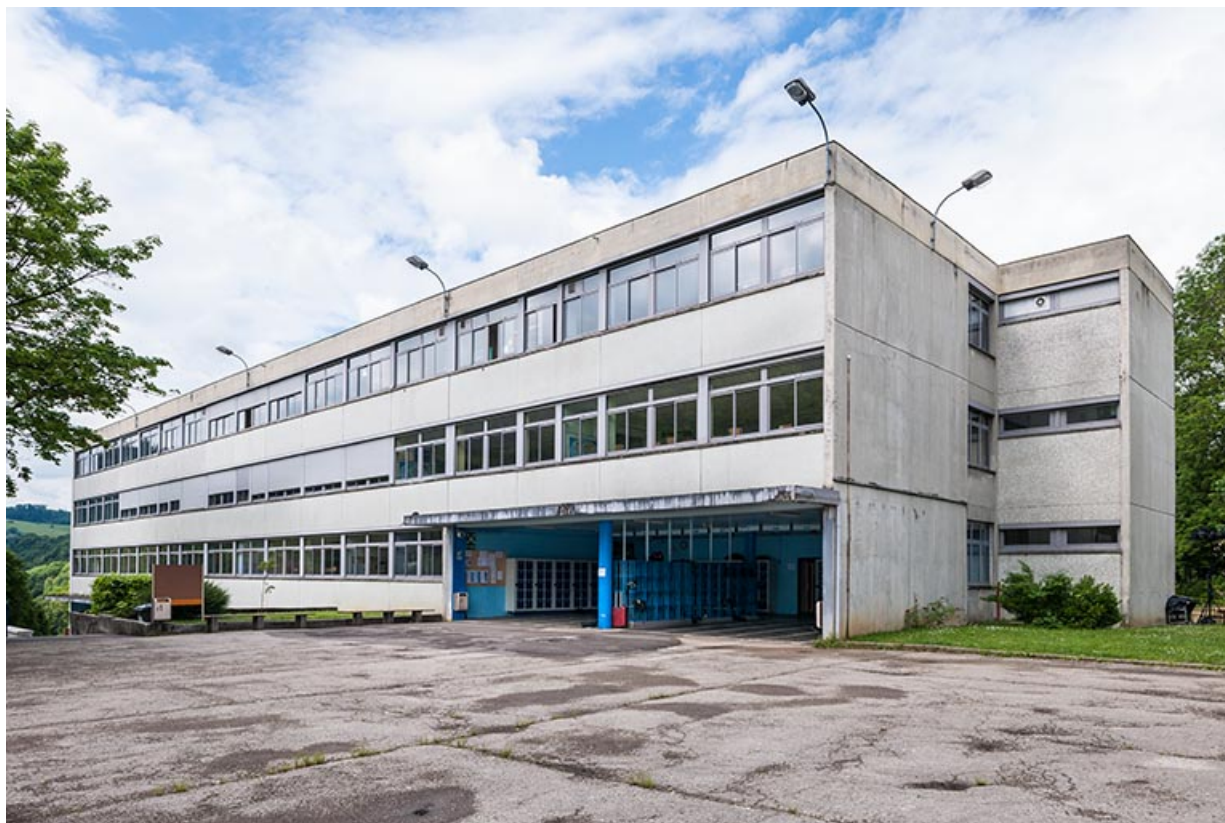
Cour, angle nord-est et façade antérieure de l'externat.
