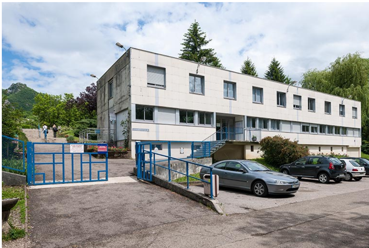
Angle sud-ouest de l'administration et sa façade antérieure.
