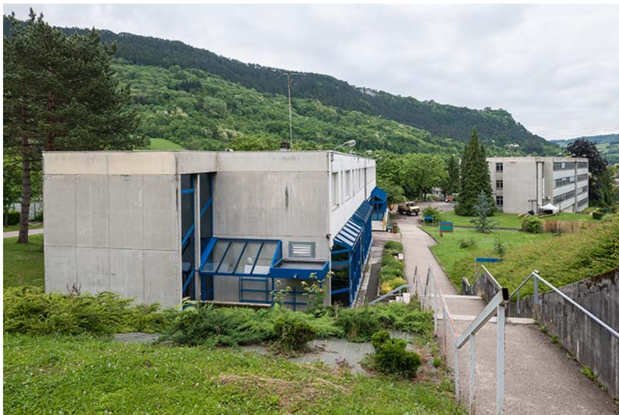
Angle nord-ouest de la restauration au premier plan et façade postérieure de l'externat au second plan. 39, Salins-les-Bains route d' Ornans, lieudit : Margillens du Bas-Est
