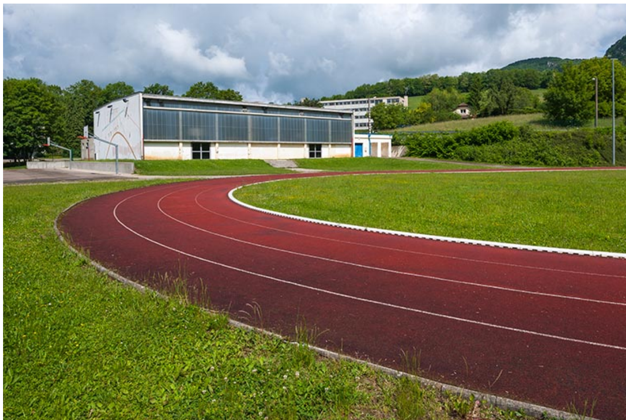
Piste d'athlétisme, stade et façade postérieure est du gymnase.
