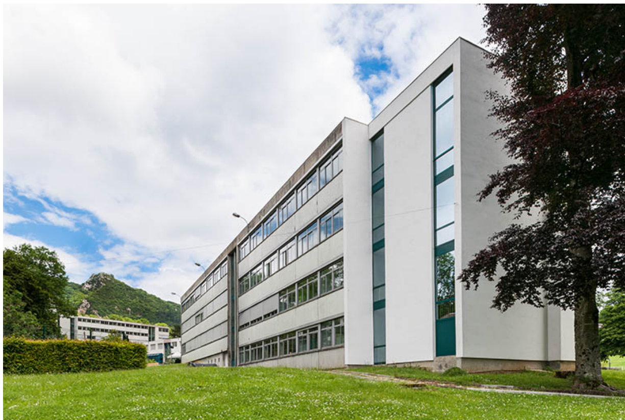
Façade postérieure de l'externat depuis son angle sud-ouest. 39, Salins-les-Bains route d' Ornans, lieudit : Margillens du Bas-Est
