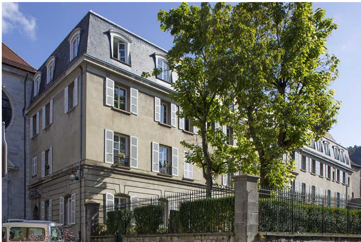
Site des jacobins : façade antérieure, à gauche entrée de la chapelle des Jacobins.
