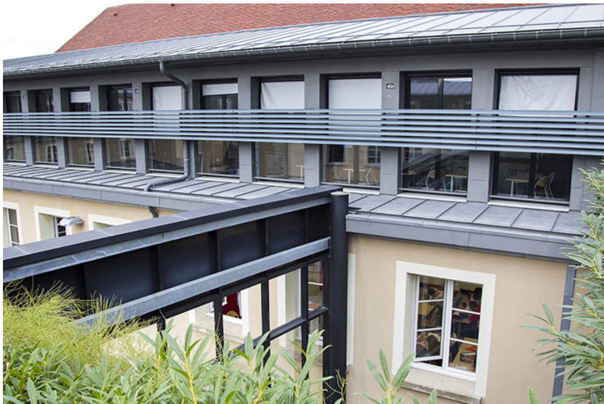
Surélévation de l'aile Nord : détail de la jonction entre façades au dernier étage.
