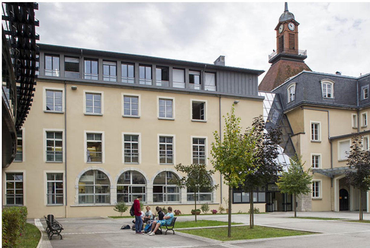
Aile Sud : façade sur cour, verrière sur la façade postérieure du hall d'entrée de la place des déportés. 39, Poligny, 3 rue Hyacinthe Friant
