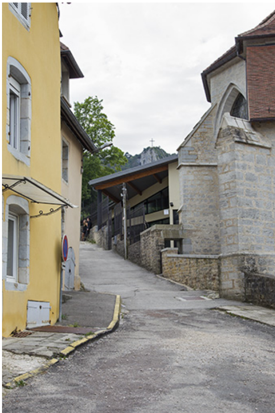
Aménagement du lycée sur la partie postérieure Est jouxtant le chevet de la chapelle des jacobins. 39, Poligny, 3 rue Hyacinthe Friant
