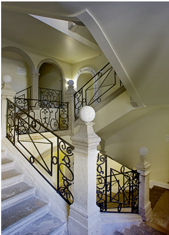
Escalier monumental rampe sur rampe dans l'aile Sud des jacobins faisant la jonction celle de l'Ouest. 39, Poligny, 3 rue Hyacinthe Friant
