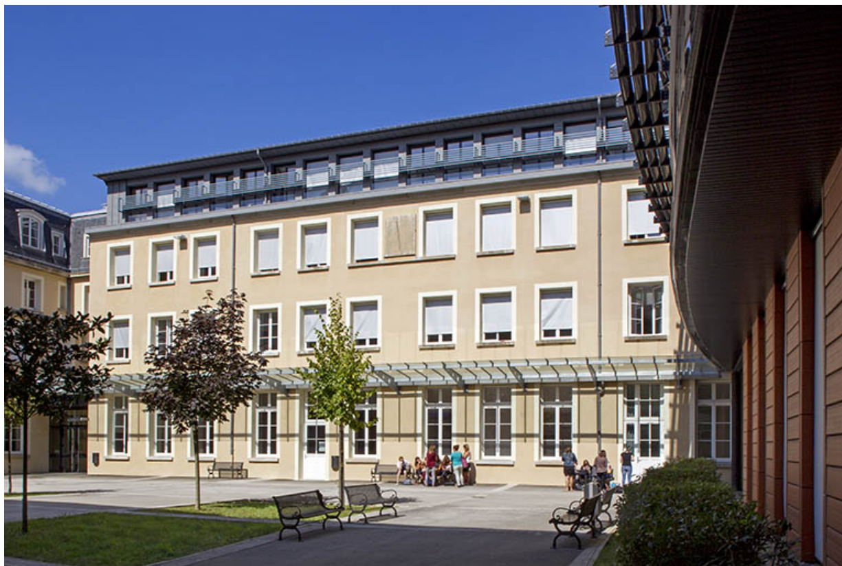
Aile Nord : vue depuis le fond de cour .
