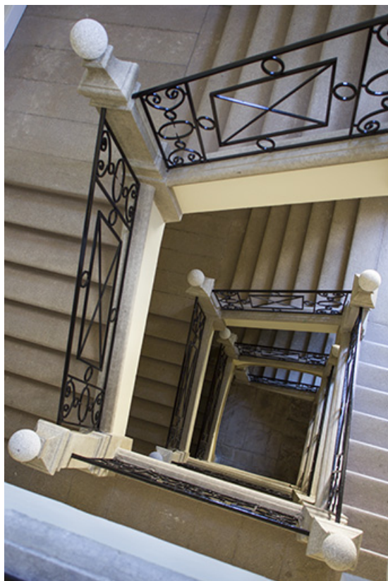
Escalier monumental : vue du dessus, détail des ferronneries.
