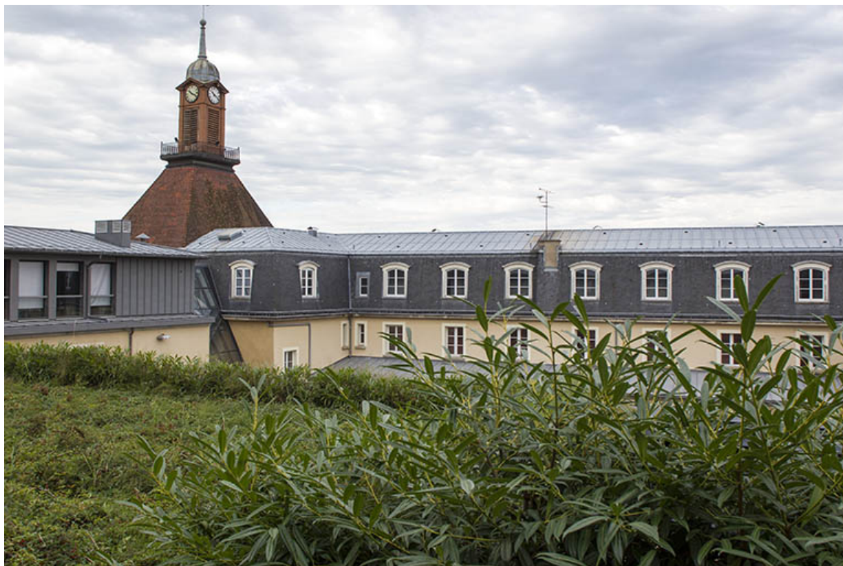
Toitures du qualidratère des jacobins au 1er plan, la toiture végétalisée de l'aile Nord.
