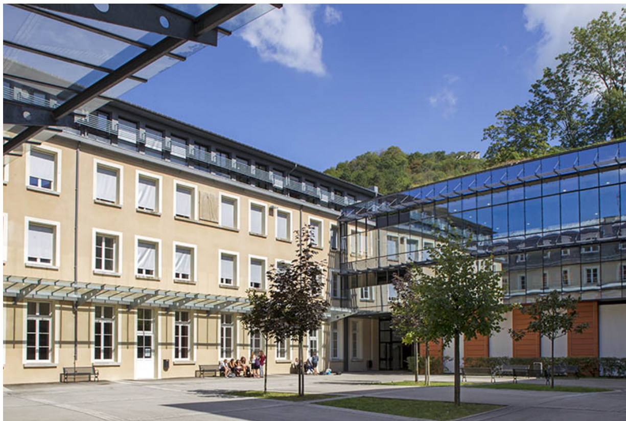
Aile Nord : façade antérieure sur cour, avec auvent.
