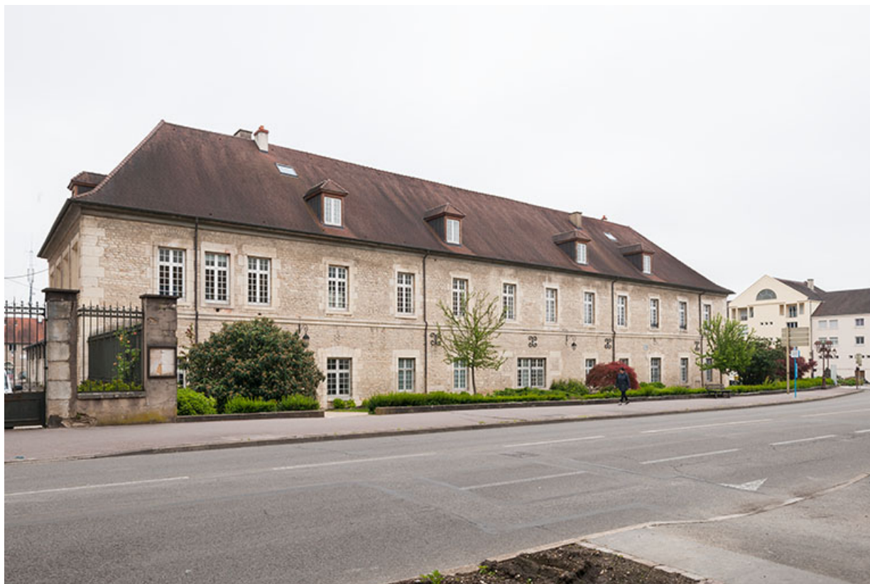
Atelier-externat : façade sur la rue des Arènes.
