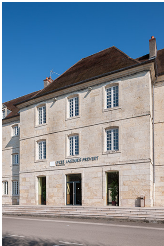
Avant-corps central de la façade postérieure de l'externat.
