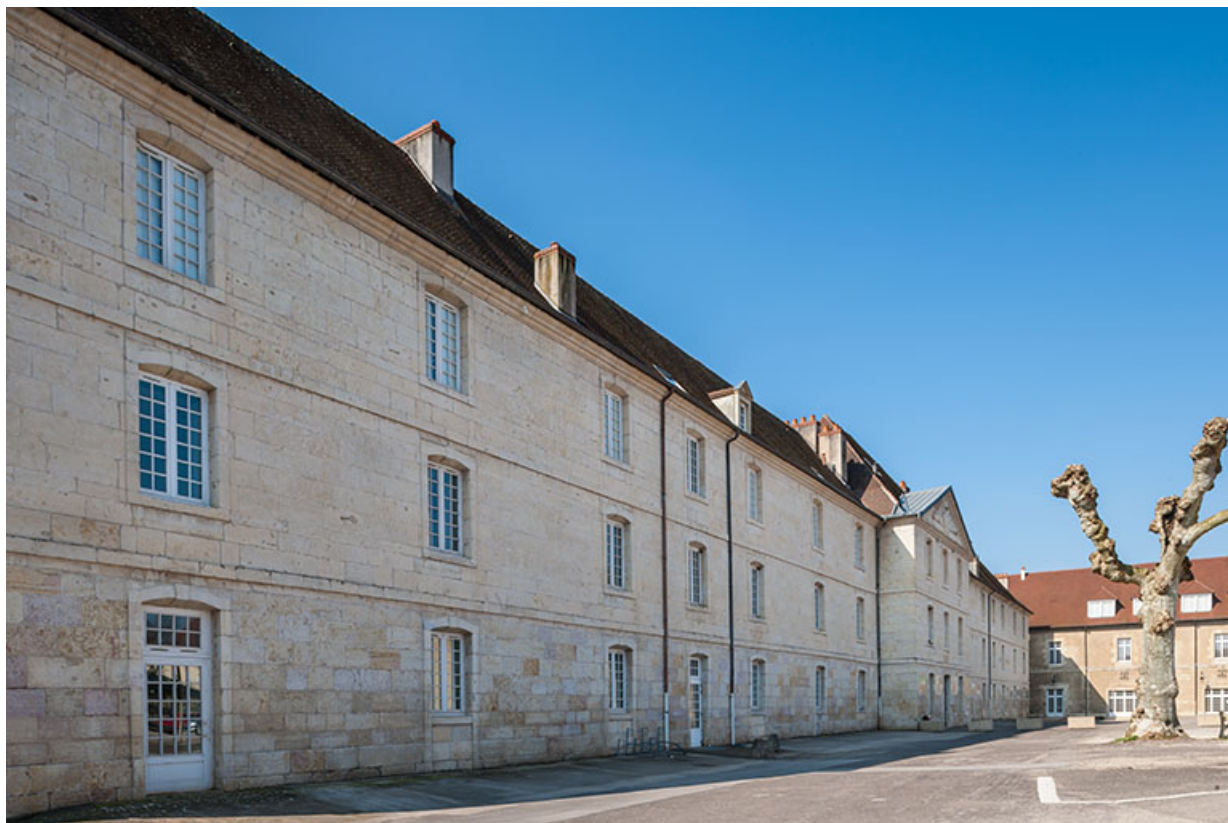
Externat : Vue 3/4 façade antérieure, place Précipiano.
