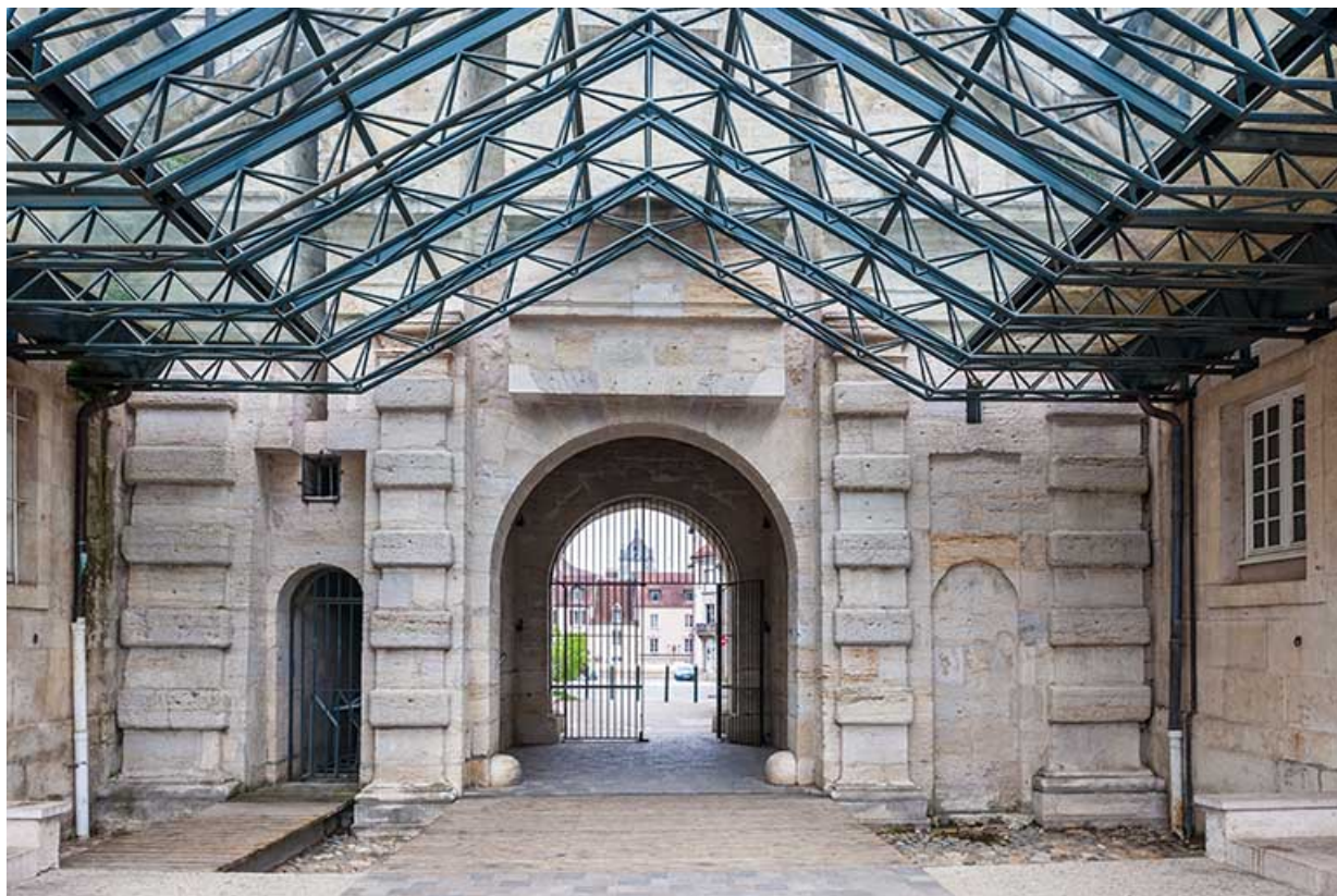
Porte d'Arens : vue postérieure avec aménagement du passage couvert.
