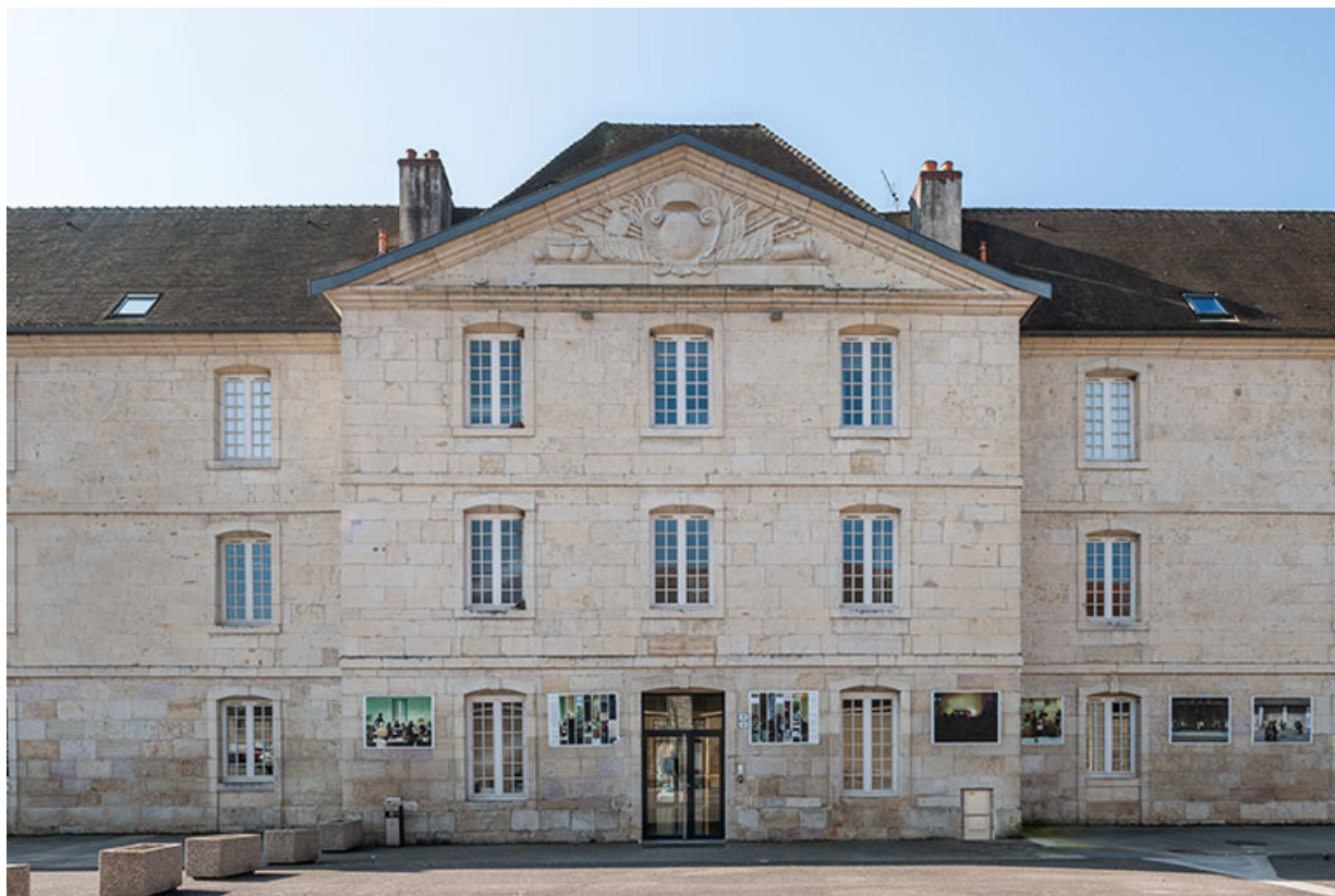
Externat-administration : avant -corps central de la façade antérieure, place Précipiano.
