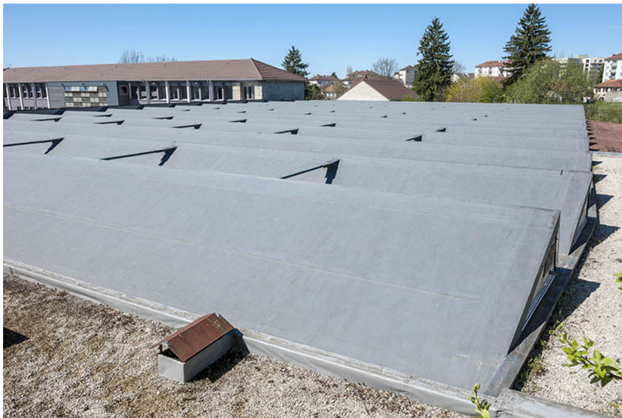
Atelier, site Edouard Herriot, toiture en sheds.
