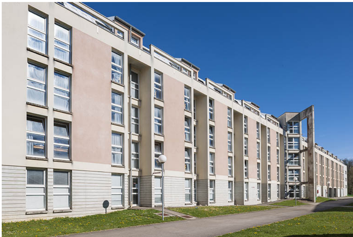
Internat : Façade antérieure, vue perspective. 39, Champagnole, 625 avenue de Gottmadingen
