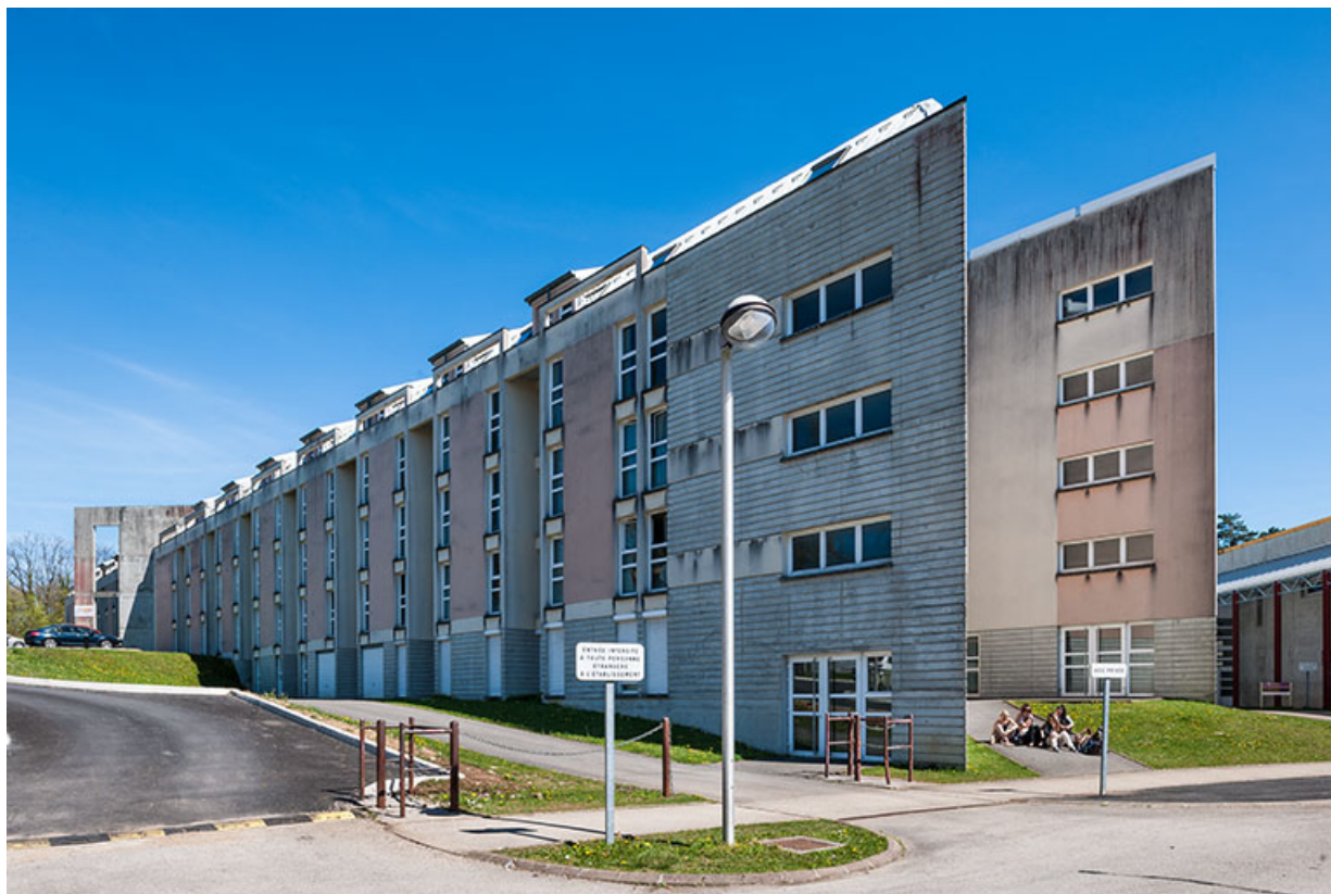
Internat : vue d'ensemble depuis la rue des Liegettes.
