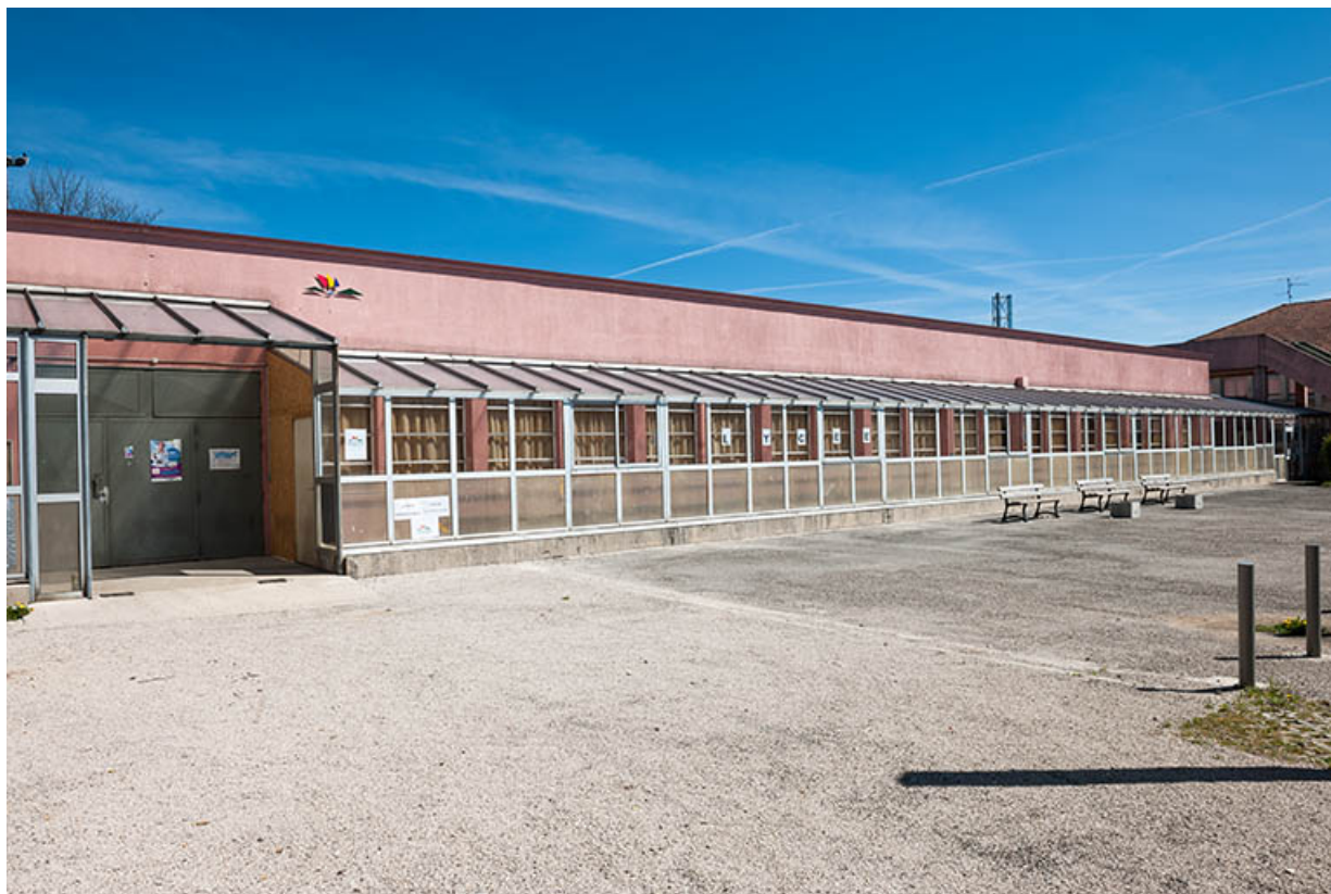
Atelier, site avenue Edouard Herriot, façade antérieure et cour
