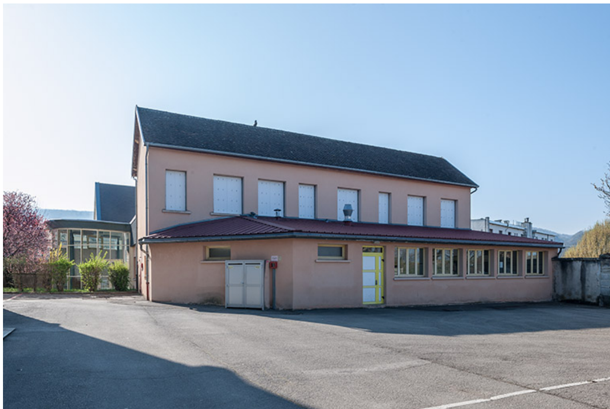
Restaurant d'application : ensemble des bâtiments, vue depuis la cour.
