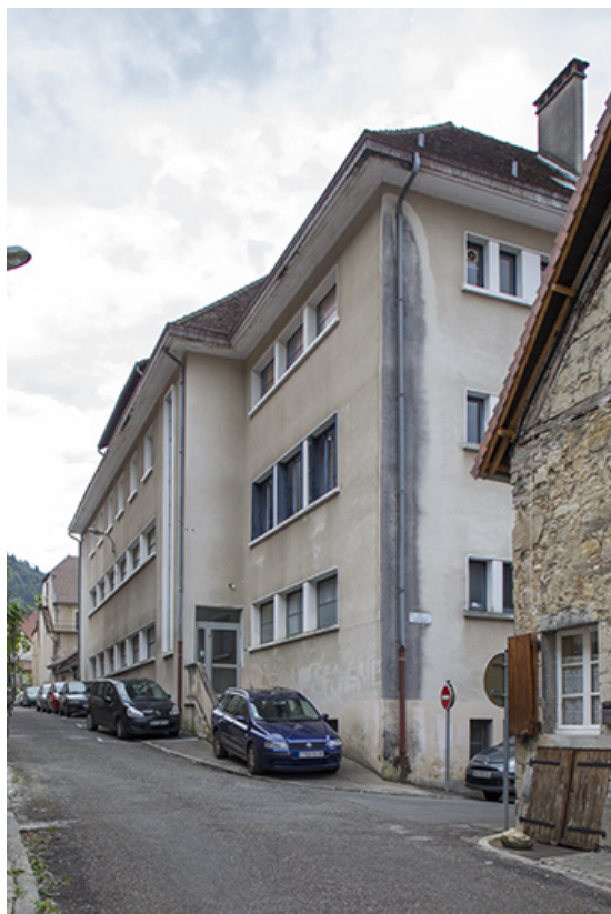
site des oratoriens : façades Nord des bâtiments, rue de la comédie. 39, Poligny, 42 rue du Collège
