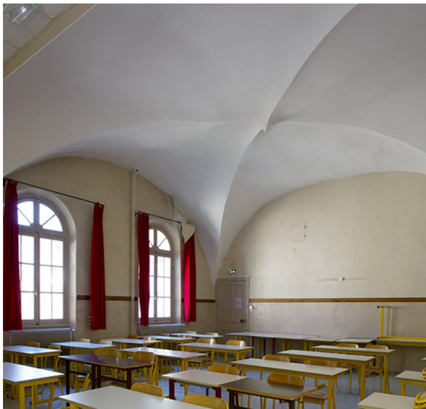
Site des oratoriens : salle de classe, dite de la chapelle.
