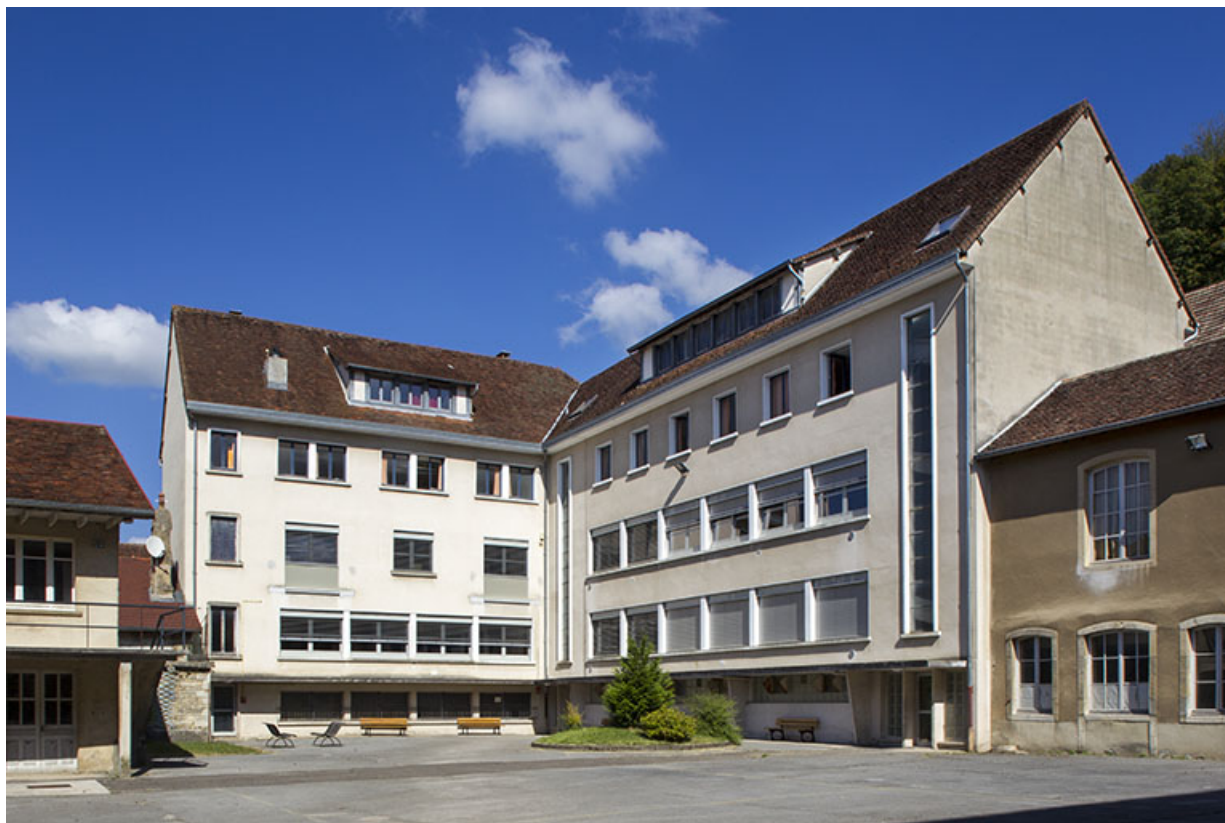
Site des oratoriens : bâtiments modernes fermant l'angle nord-est de la cour. 39, Poligny, 42 rue du Collège
