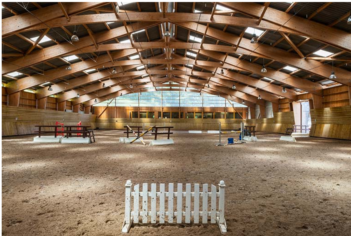
Centre équestre : manège, vue intérieure avec charpente en lamellé collé.
