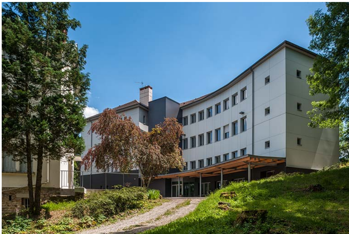
Externat : aile ouest, façade postérieure après rénovation , ajout d'un auvent et parements isolants.
