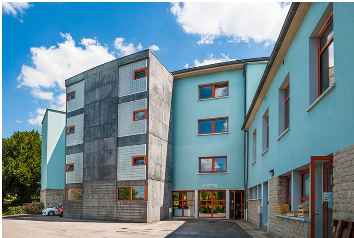
Internat : avant-corps et aile ouest de la façade postérieure.
