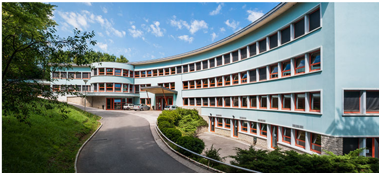
Internat : vue d'ensemble, façade antérieure. 39, Lons-le-Saunier, 410 montée Gauthier Villars
