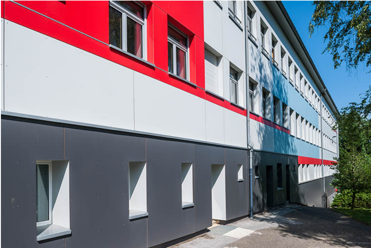
Externat : façade antérieure avec parements isolants de couleur.
