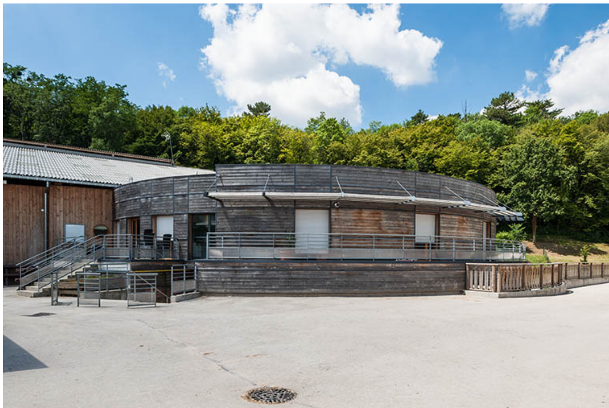
Centre équestre : façades bois de la rotonde d'accueil du manège.
