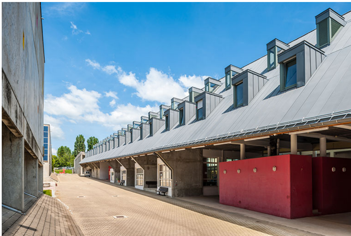
Façade sur rue intérieure du bâtiment internat - administration : toiture métallique avec chien-assis 39, Lons-le-Saunier, rue 255 Charles Ragmey
