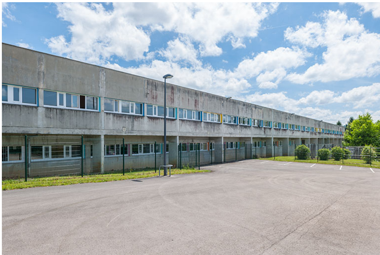
Vue du bâtiment internat -administration depuis la rue Charles Ramey. 39, Lons-le-Saunier, rue 255 Charles Ramey
