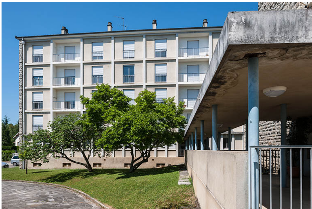
Cour intérieure : à droite gymnase, au fond bâtiment administration-logements.
