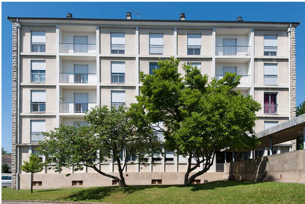
Bâtiment administration-logement : façade postérieure avec liaison vers le bâtiment principal.
