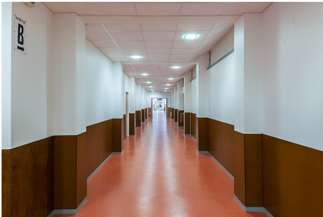
Couloir d'accès au hall d'entrée, rez-de-chaussée.
