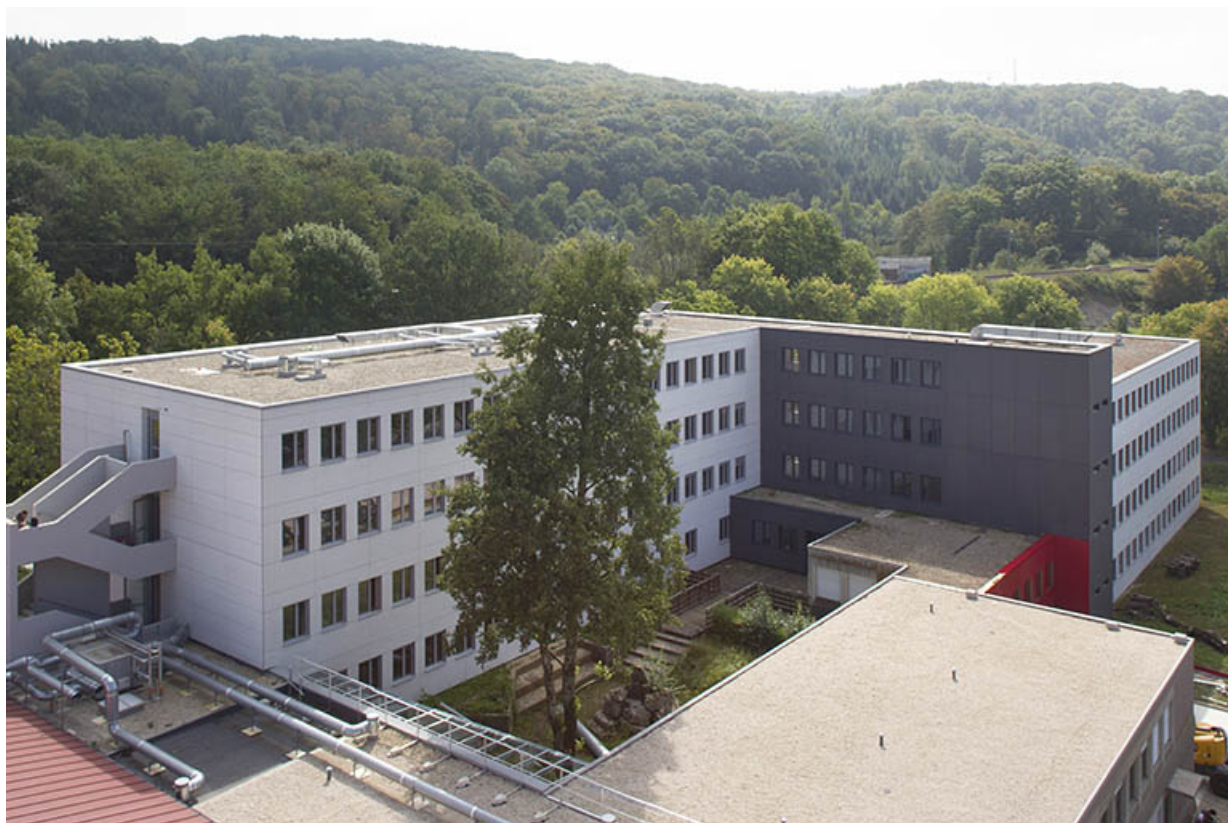
Internat : vue générale après restauration des façades.
