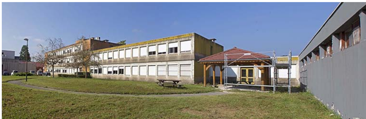
Externat : façade postérieure.
