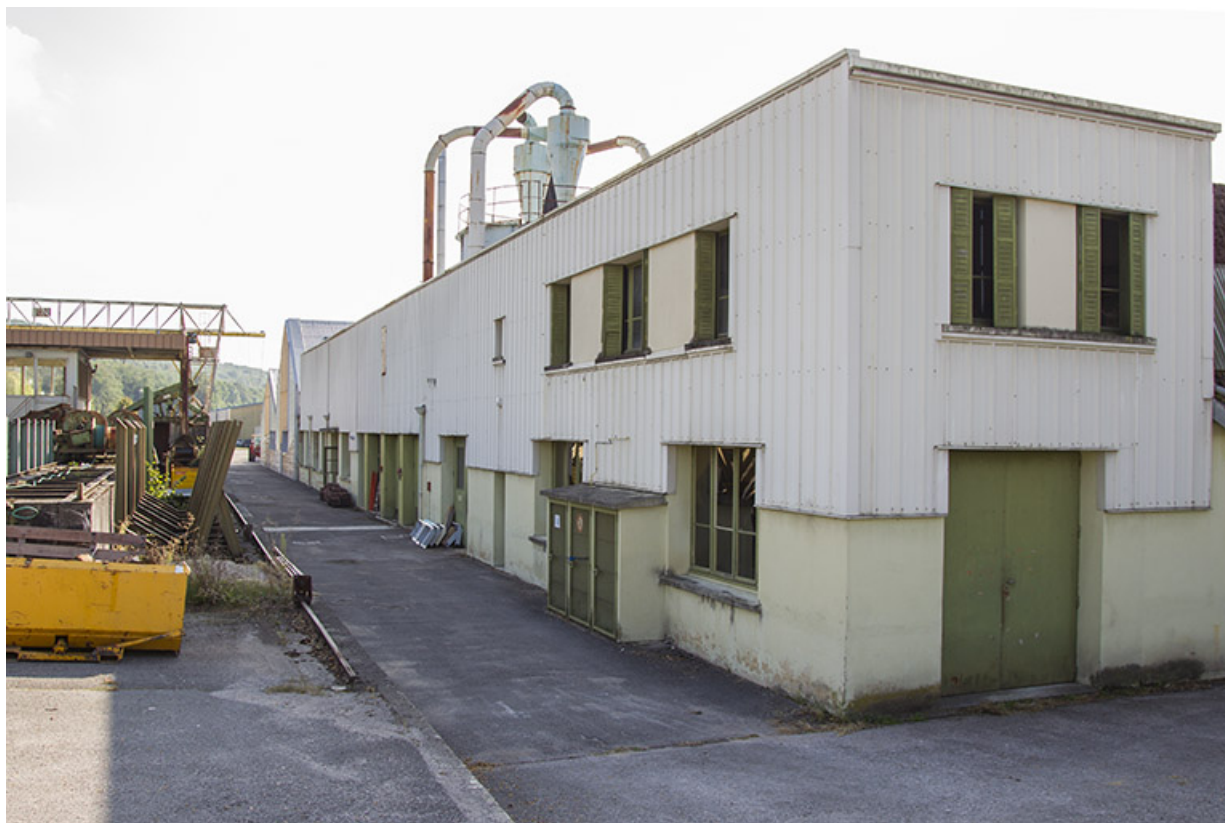
Atelier construction : façade antérieure et pignon nord.
