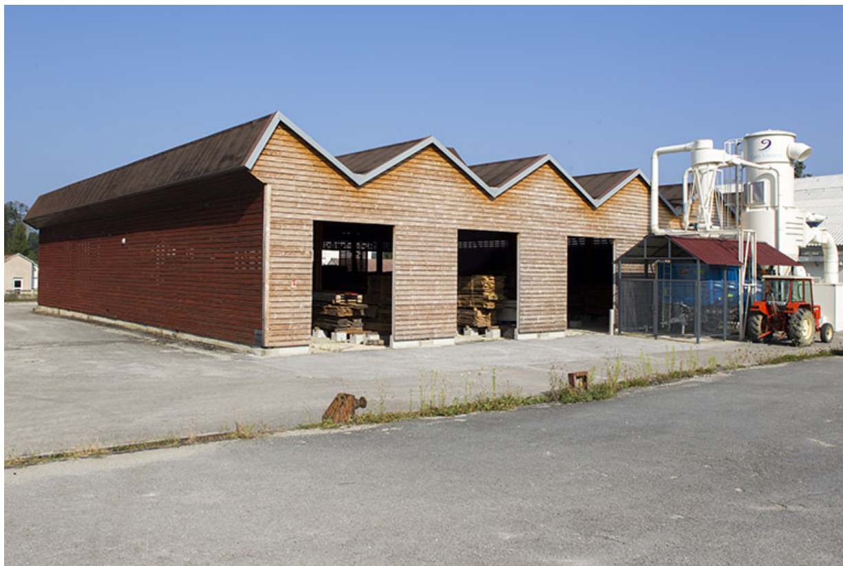
Bâtiment de stockage du bois et atelier, façades antérieures.
