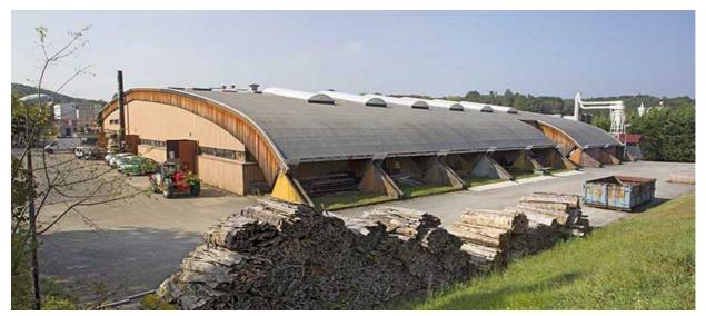
Atelier : couverture avec charpente en lamellé collé.
