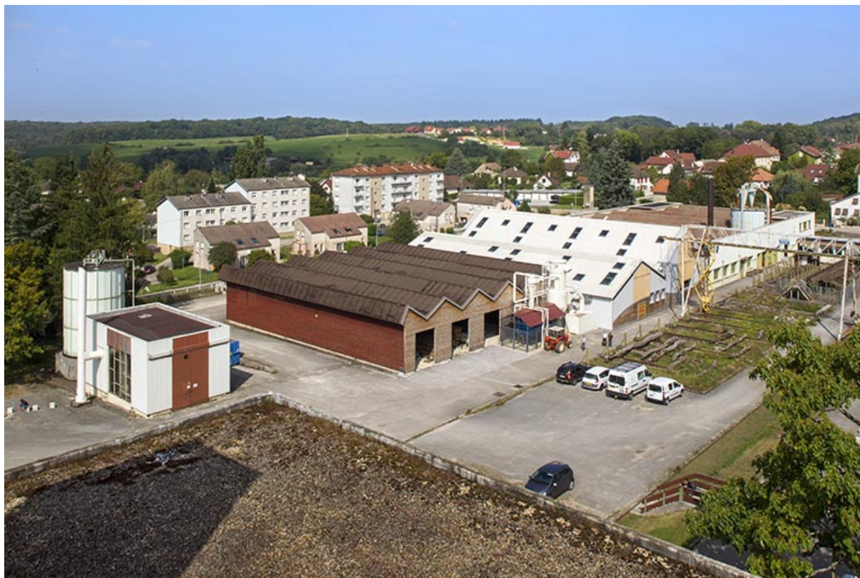
Chantier de grumes at ateliers : vue générale.
