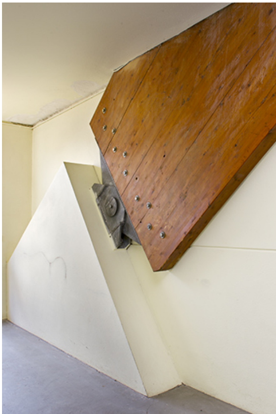
Atelier : détail de la culée de charpente, intérieur.
