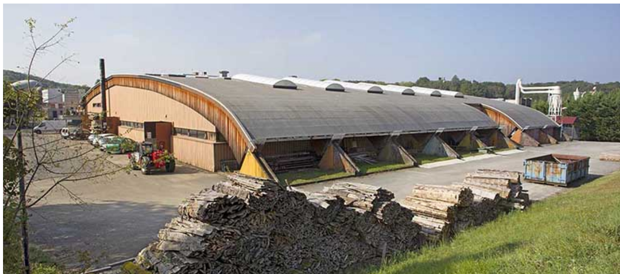
Atelier : couverture avec charpente en lamellé collé.
