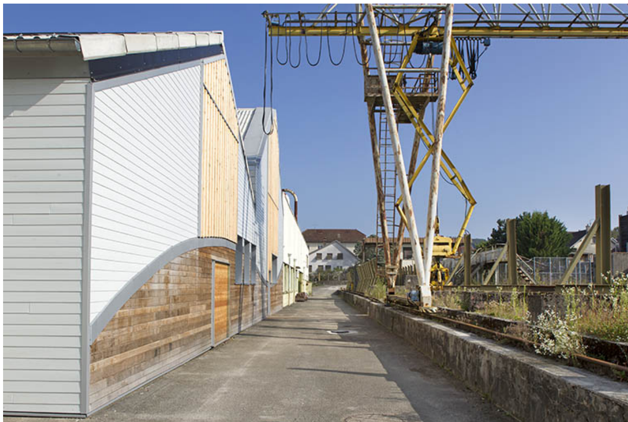
Atelier : façade antérieure et détail pont roulant.
