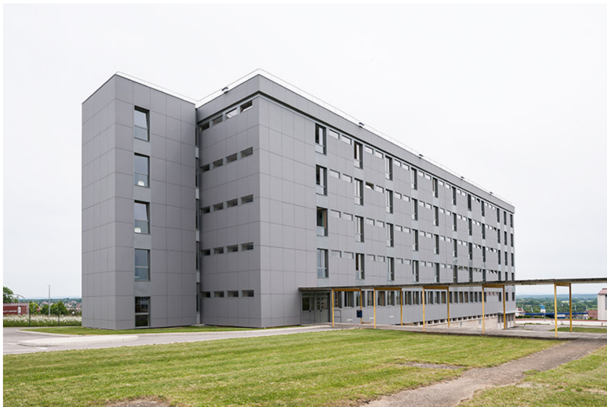
Internat : façade antérieure et pignon nord, passage vers l'externat-restauration.
