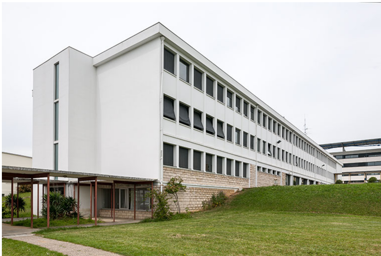
Externat : ancien bâtiment, pignon sud.
