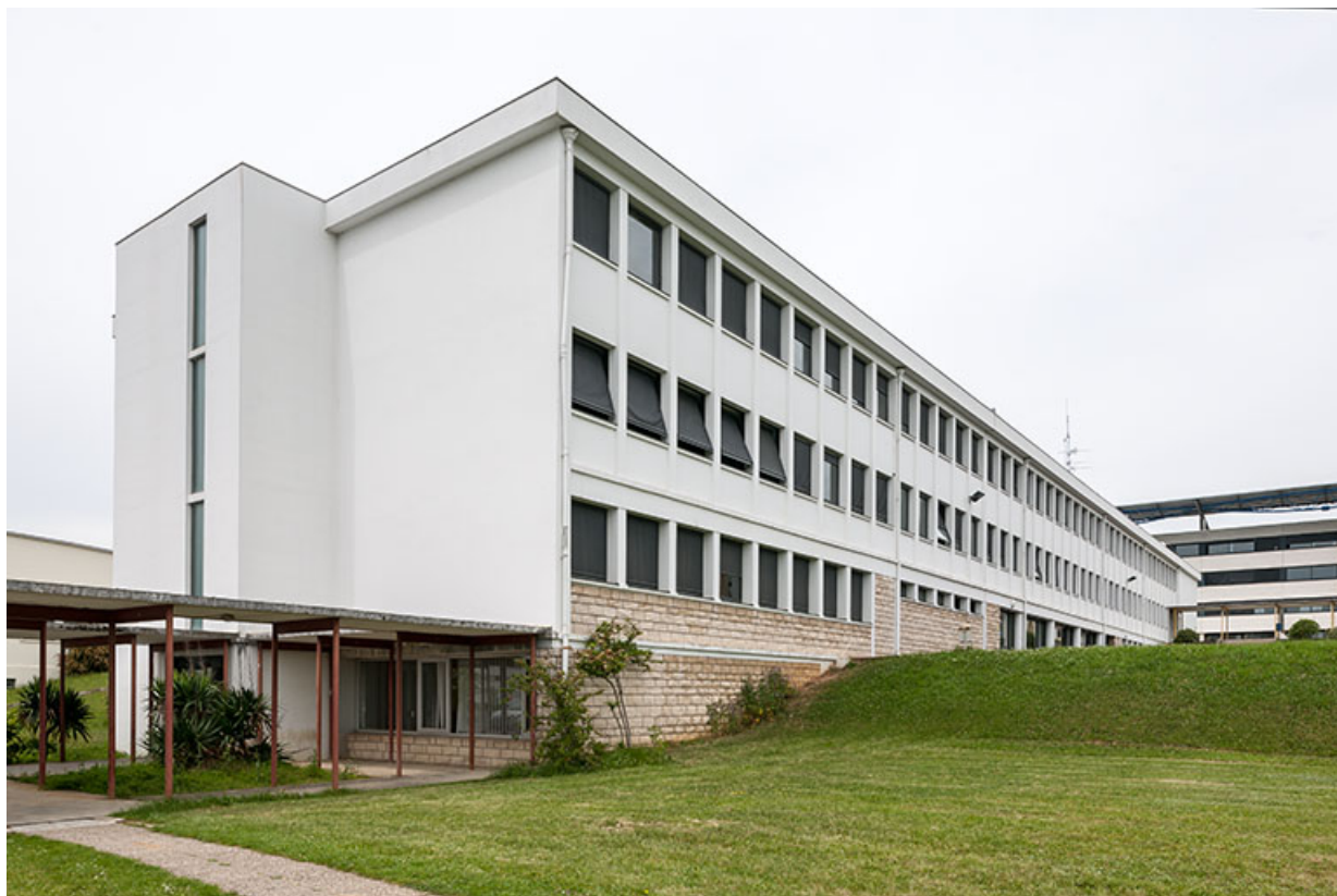
Externat : ancien bâtiment, pignon sud.
