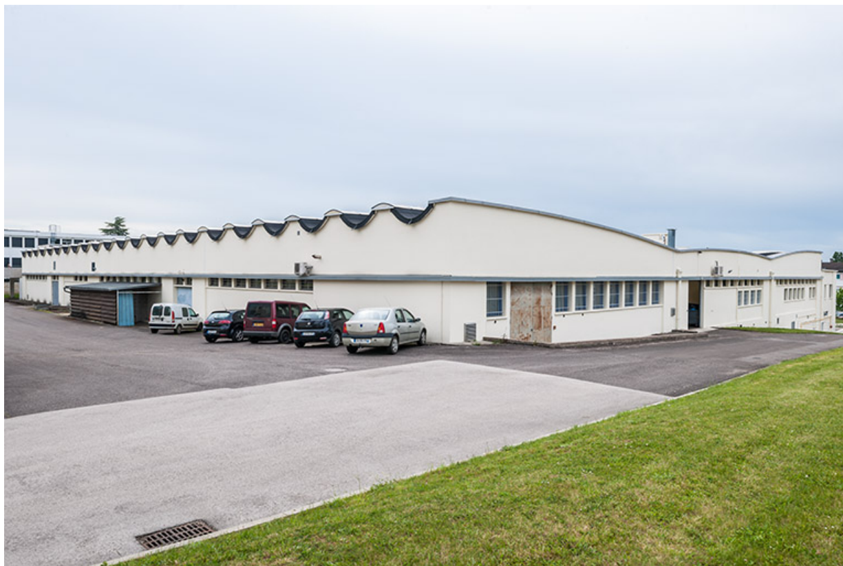
Ateliers : vue générale des façades arrière.
