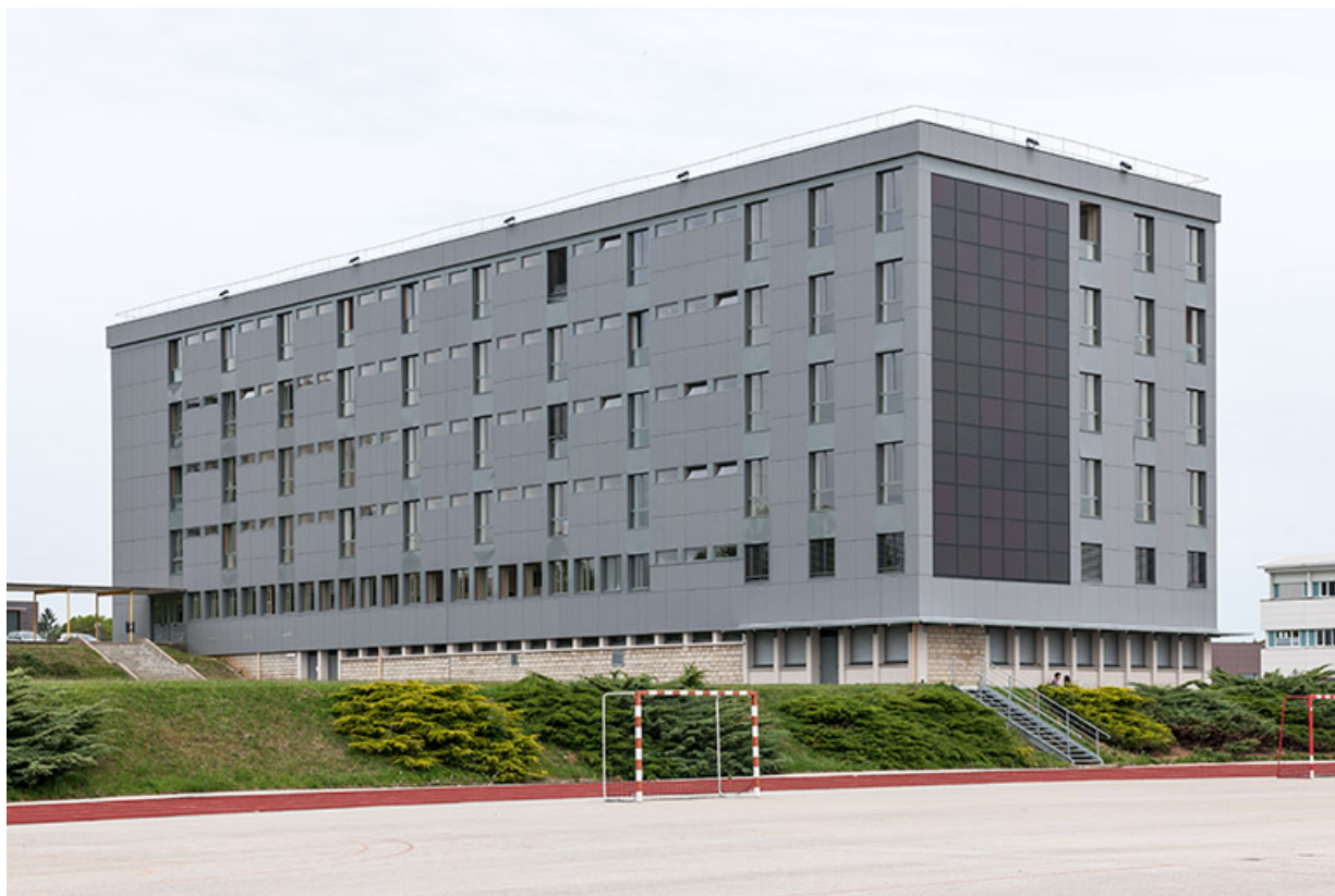
Internat : façade antérieure avec bardage et pignon sud avec panneaux photovoltaïques 39, Dole rue Charles Laurent-Thouverey
