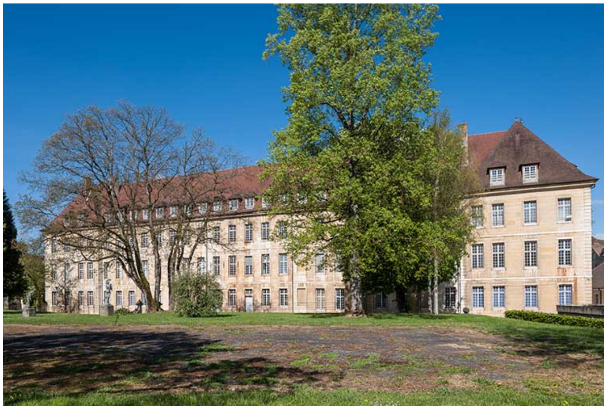
Ancien hôpital de la Charité, actuellement internat, vue postérieure sur le parc. 39, Dole, 6 Grande Rue
