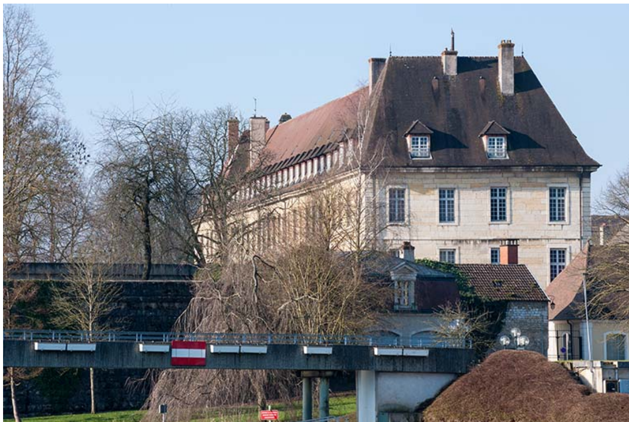
Ancien hôpital de la Charité, actuellement internat, détail des toitures. 39, Dole, 6 Grande Rue
