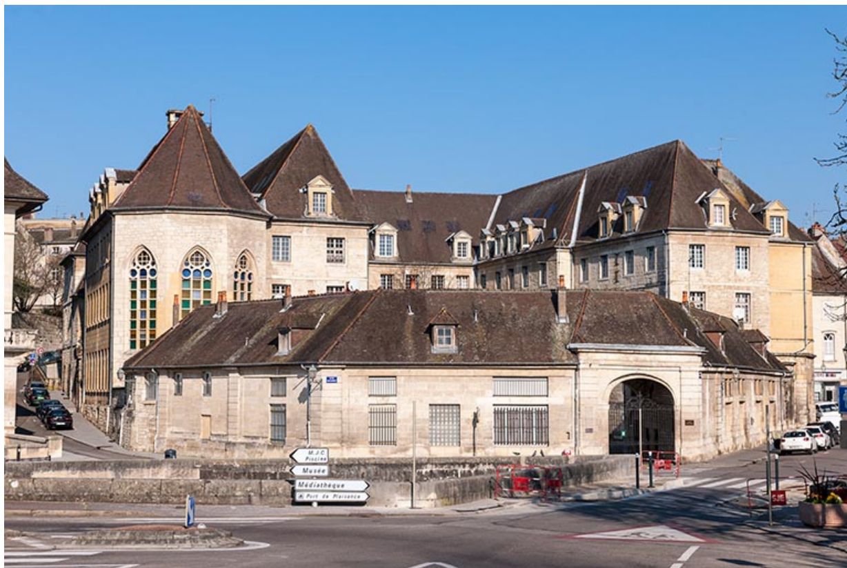
Vue générale du site occupé autrefois par le couvent des Dames d'Ounans.
