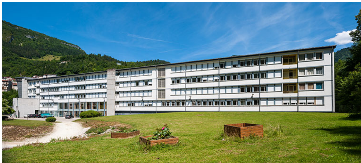
Internat : façade postérieure, vue générale.
