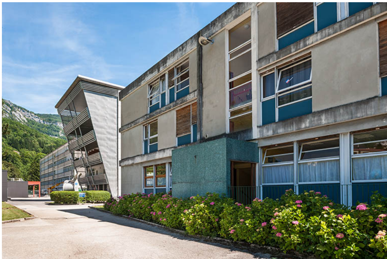
Administration : vue depuis le côté Est avec au second plan l'extension de l'internat. 39, Saint-Claude rue du Tomachon
