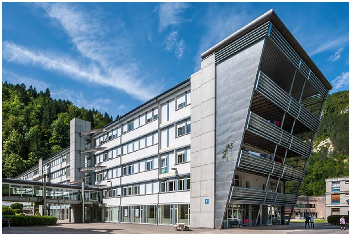
Internat : façade Est avec accroche du passage couvert vers l'externat et pignon nord avec extension. 39, Saint-Claude rue du Tomachon
