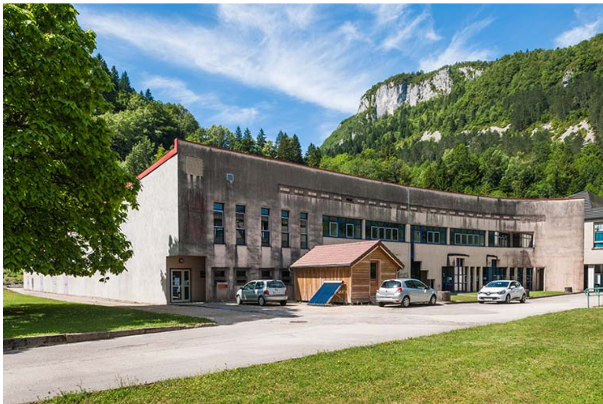
Atelier, ancien atelier mécanique : vue d'ensemble.
