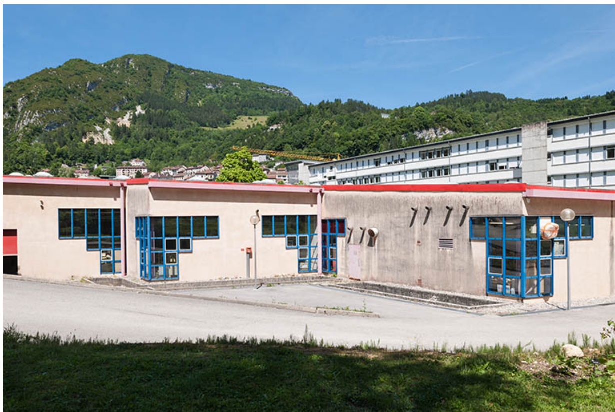
Atelier, ancien atelier mécanique : façade latérale Sud.
