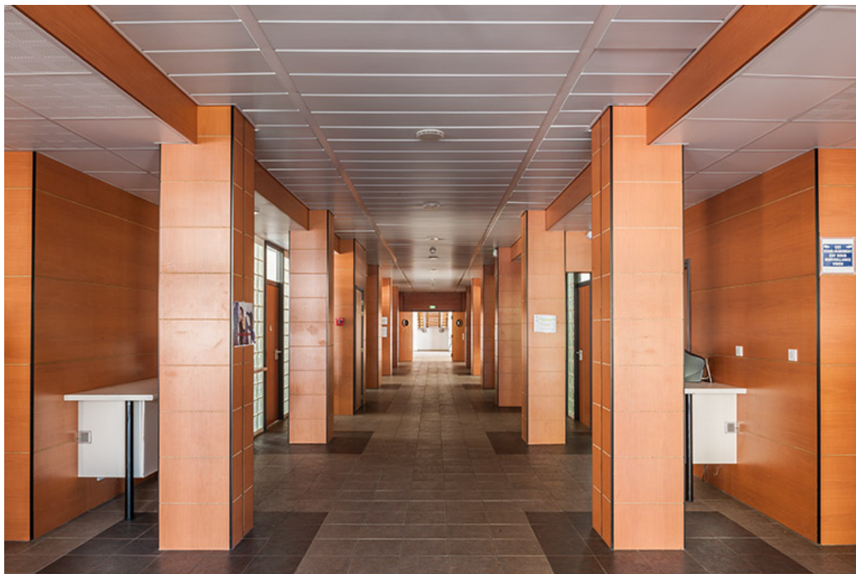
Internat : couloir du rez-de -chaussée restructuré.
