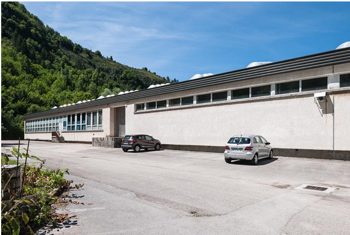
Atelier : façade postérieure.
