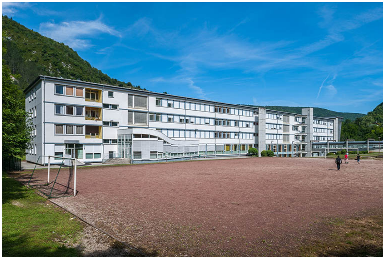
Internat : façade Est, terrain de football.
