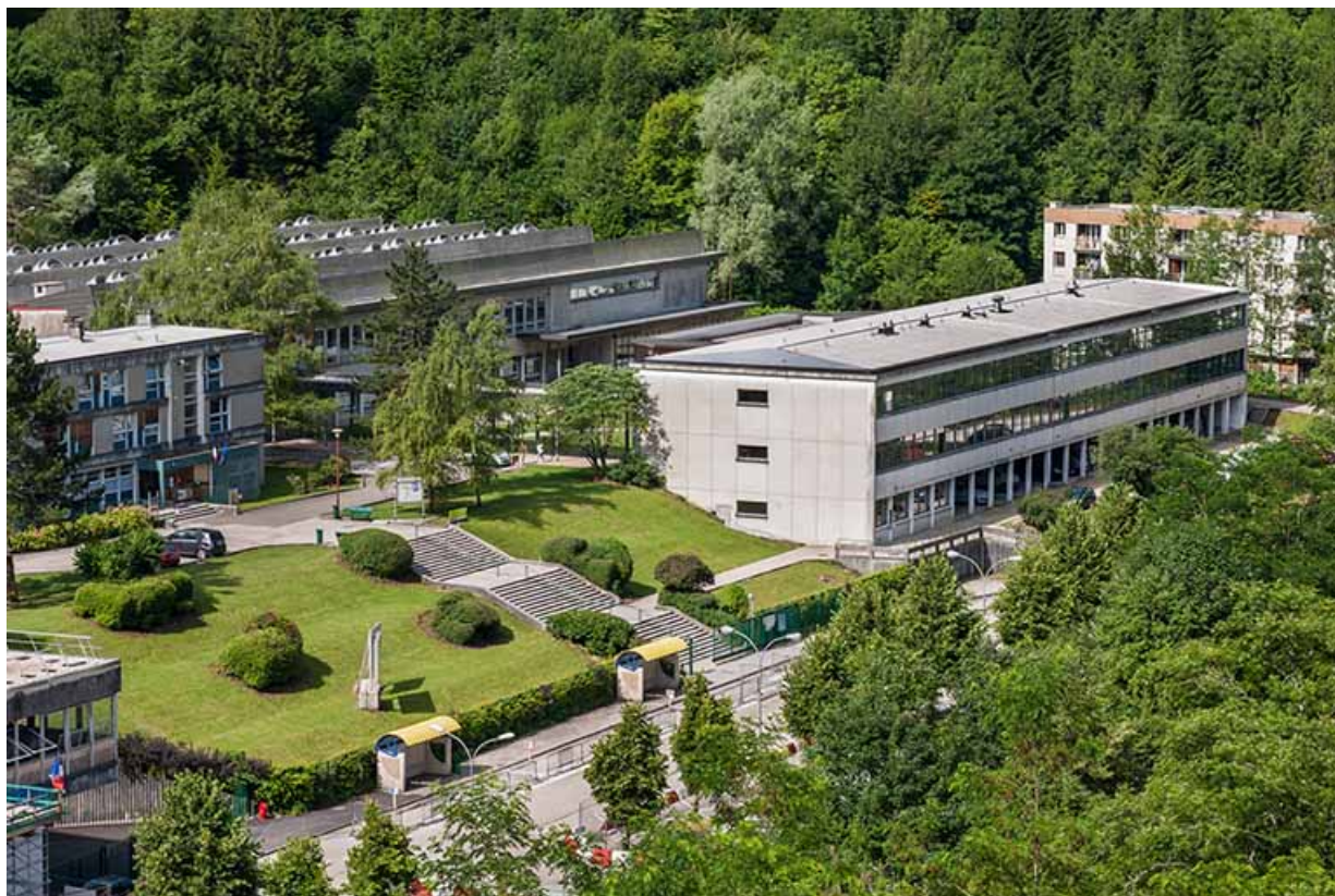
Vue de la cité scolaire : externat tertiaire au 1er plan, ateliers au second plan, à droite restauration. 39, Saint-Claude rue du Tomachon
