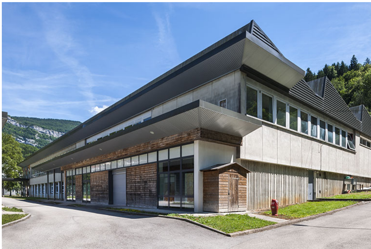
Atelier : vue d'ensemble.
