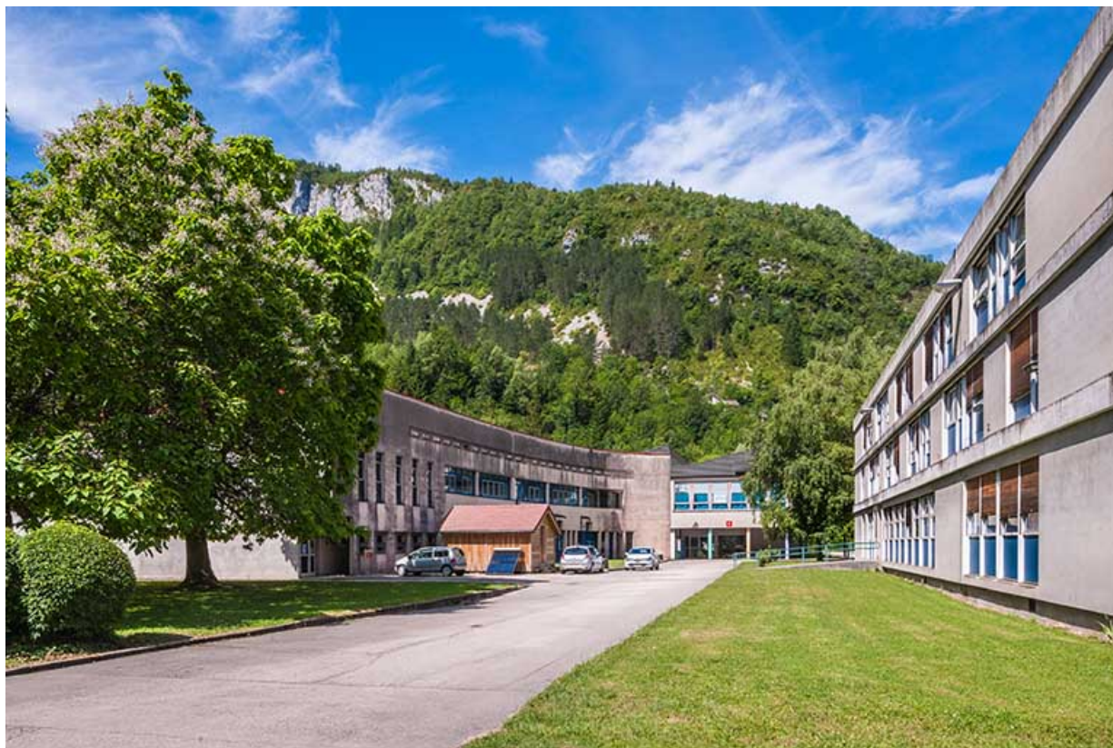
Façade postérieure de l'administration avec au second plan, les ateliers.
