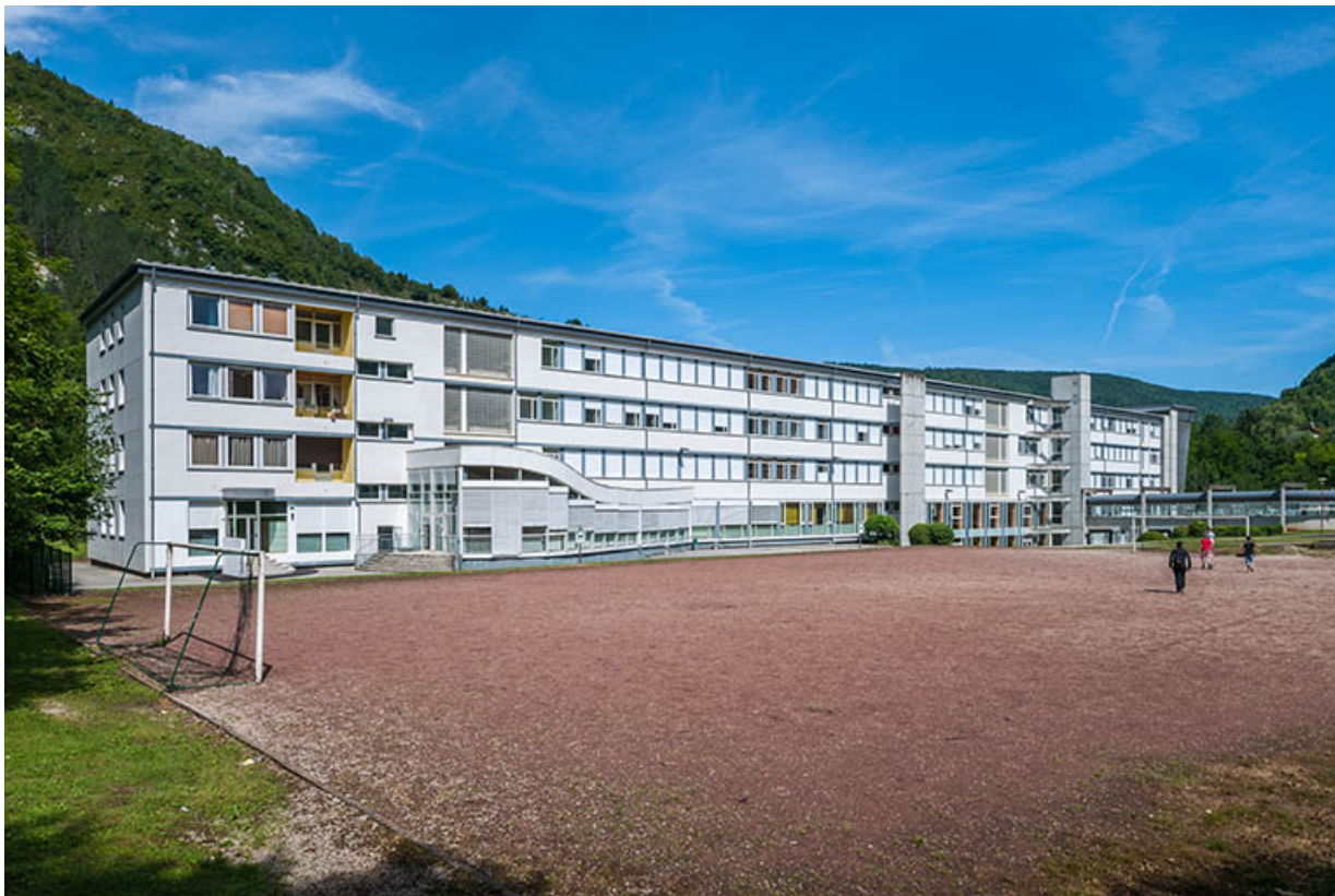
Internat : façade Est, terrain de football.
