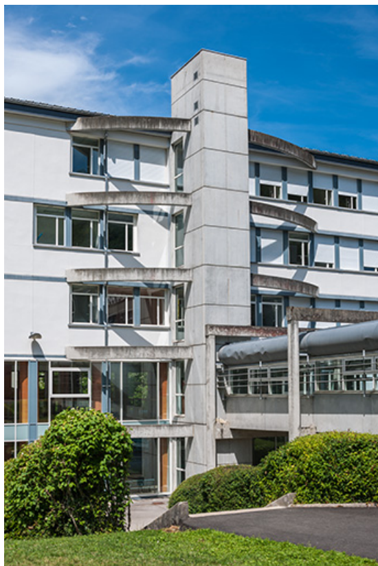
Internat : détail de la façade antérieure.
