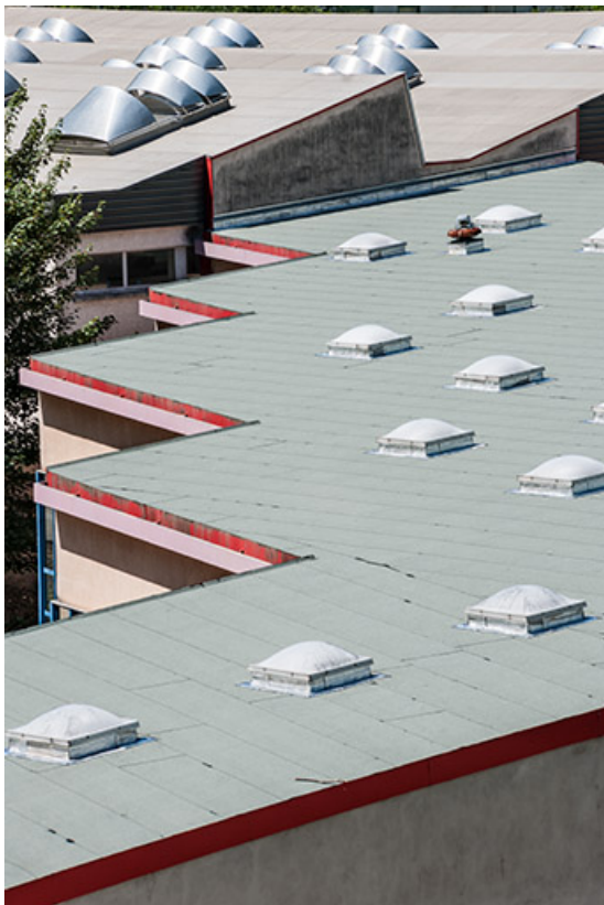
Toitures des deux ateliers : détail.
