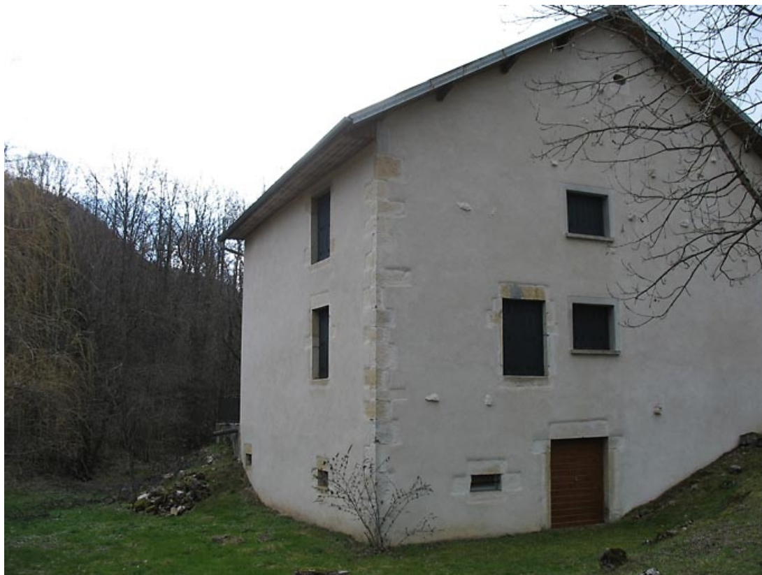
Vue de trois quarts sur pignon ouest et façade postérieure.
