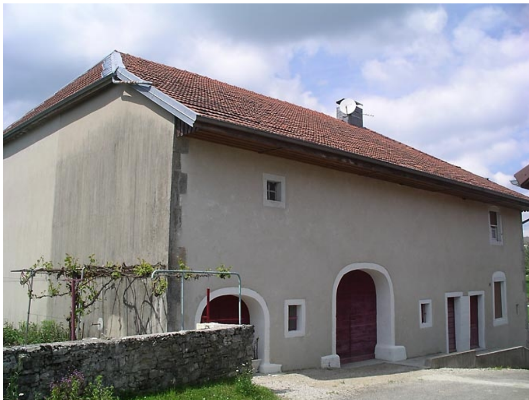
Vue de trois quarts sur façade antérieure et pignon sud-ouest.
