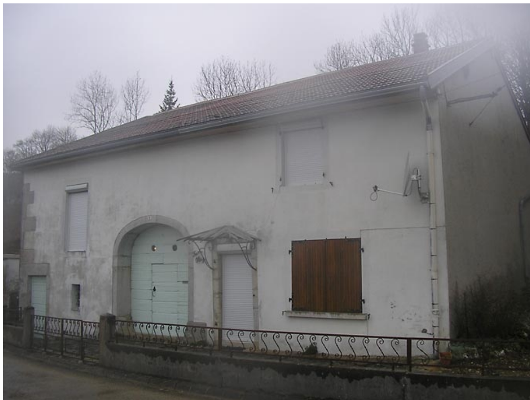
Vue de trois quarts sur façade antérieure.
