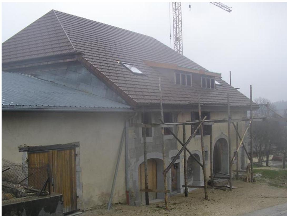
Vue de trois quarts sur façade antérieure.
