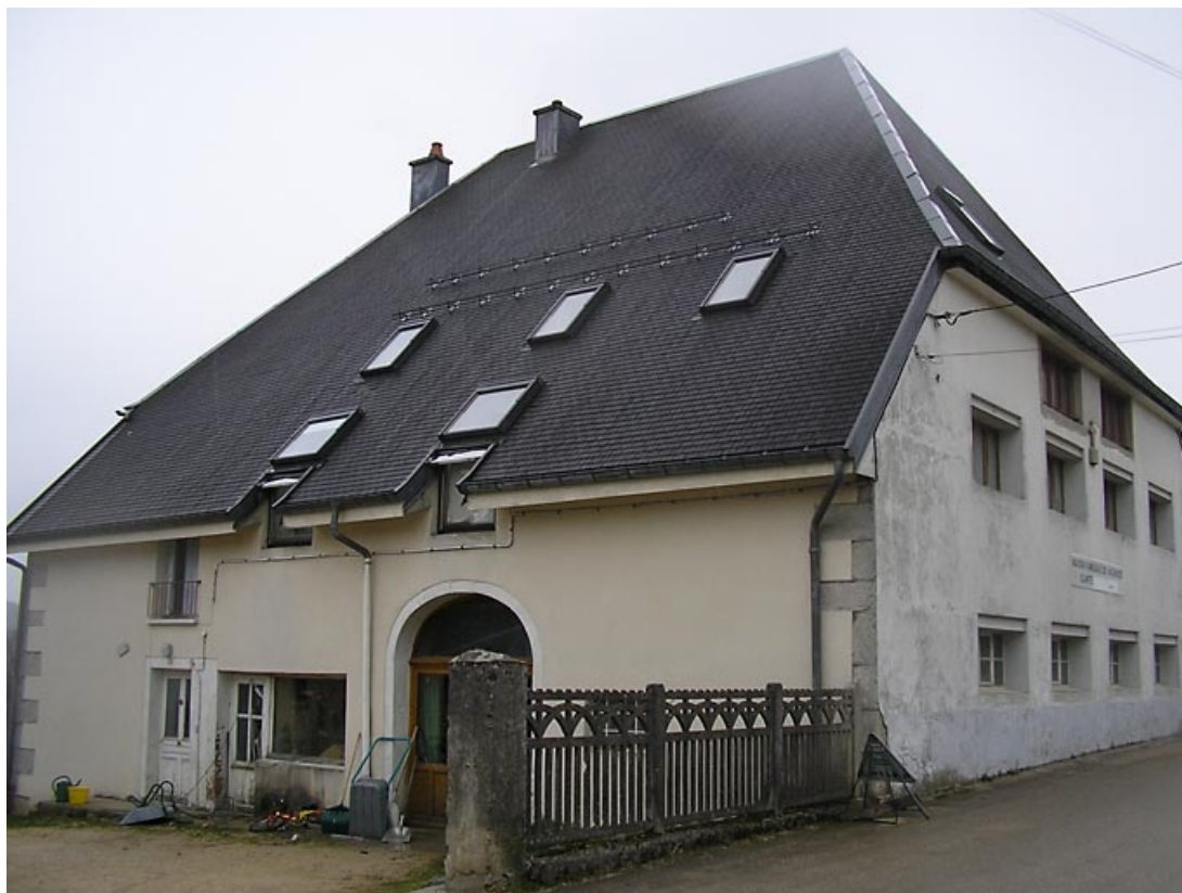
Vue de trois quarts sur façades antérieure et latérale.
