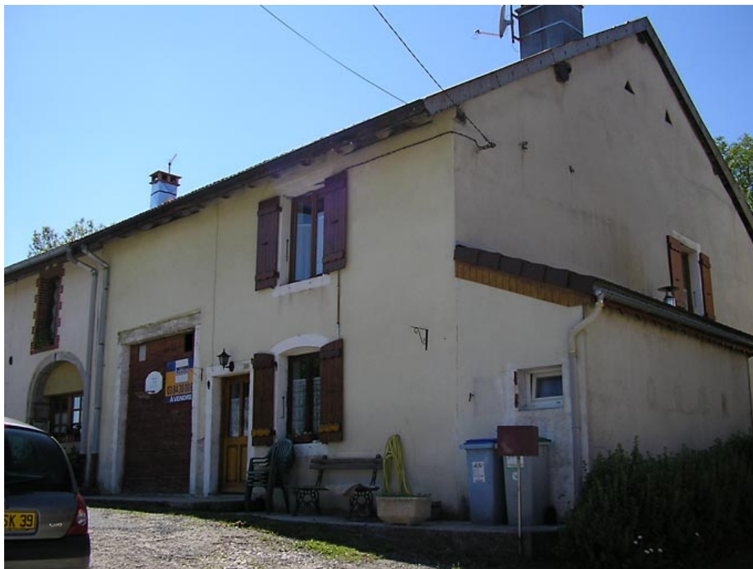
Vue de trois quarts sur façade antérieure.
