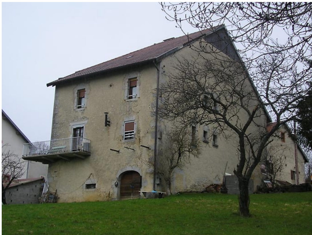
Vue de trois quarts sur façade postérieure et porte de grange.
