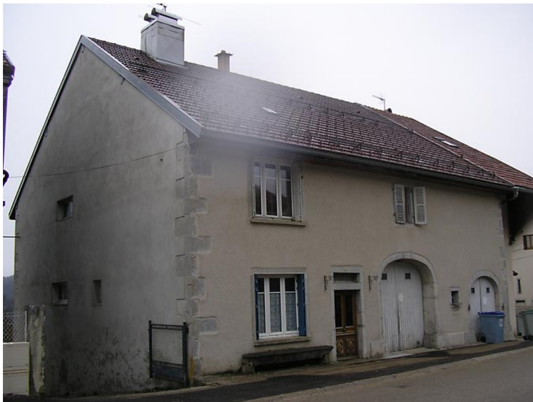
vue de trois quarts sur façade antérieure.
