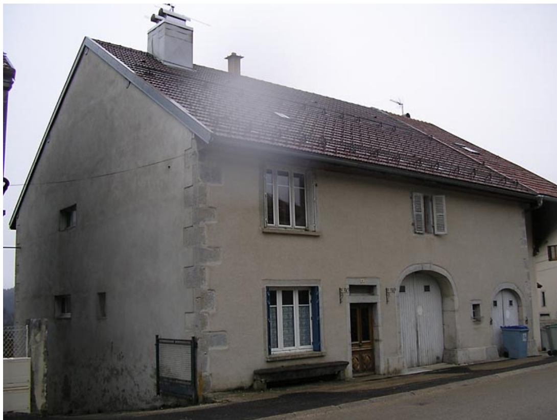
vue de trois quarts sur façade antérieure.
