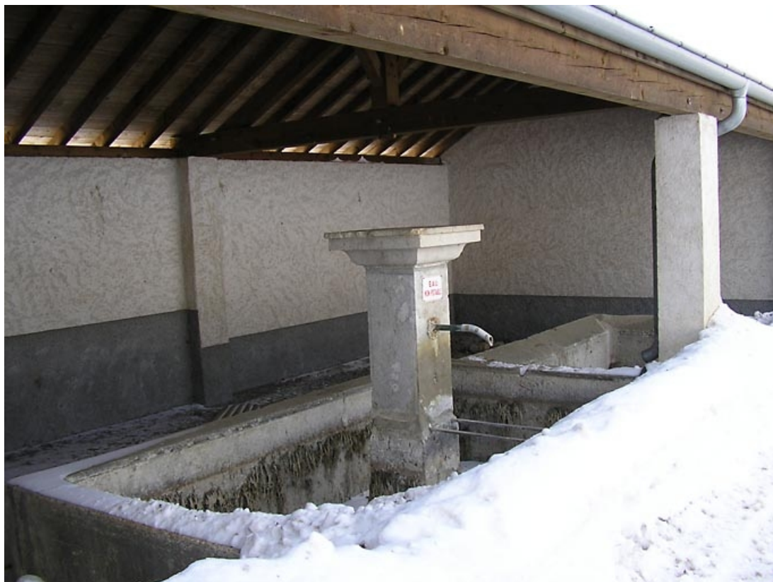
Vue de trois quarts de la fontaine et du bac.
