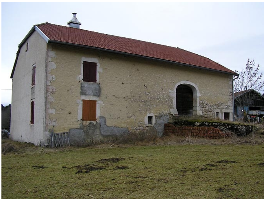
Façade postérieure et levée de grange vues de trois quarts.
