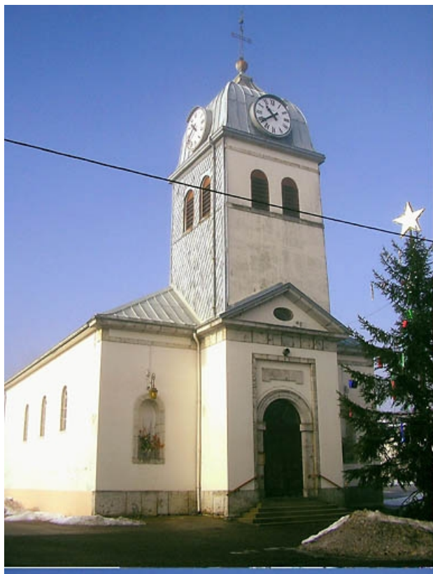
Clocher et façade latérale vus de trois quarts.
