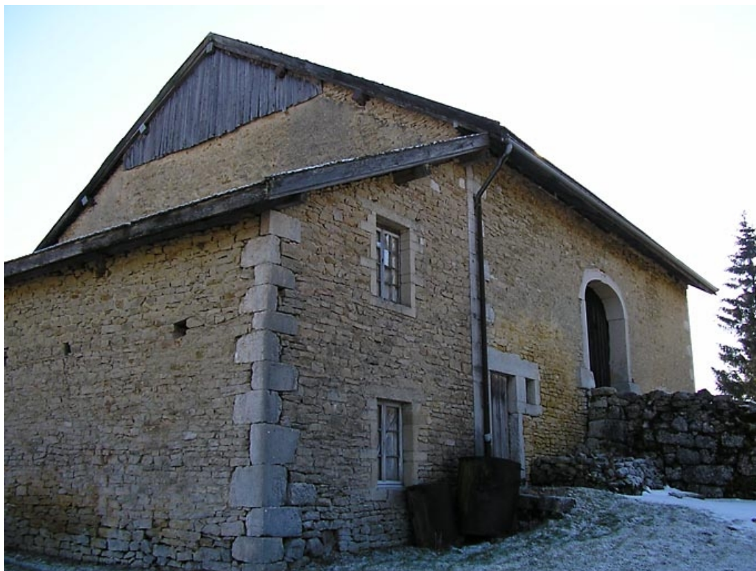
Façade postérieure et pignon essenté vus de trois quarts nord-est.
