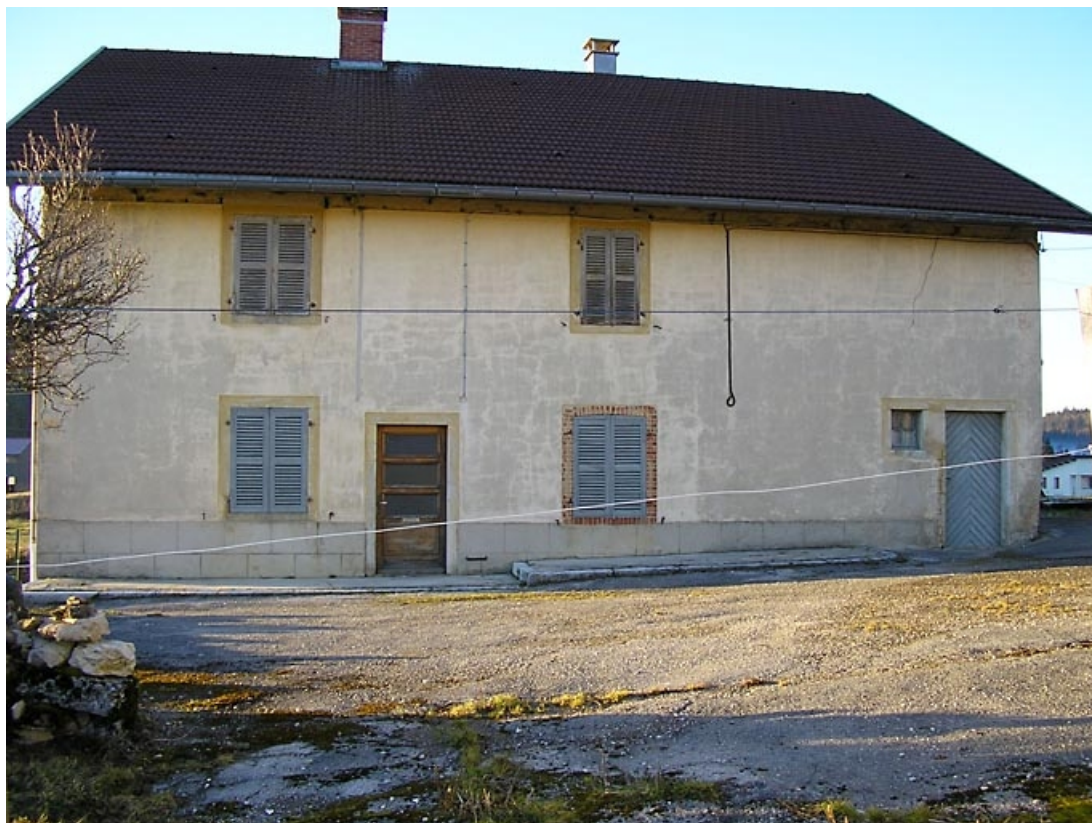
Façade antérieure. 39, Chaux-des-Prés
