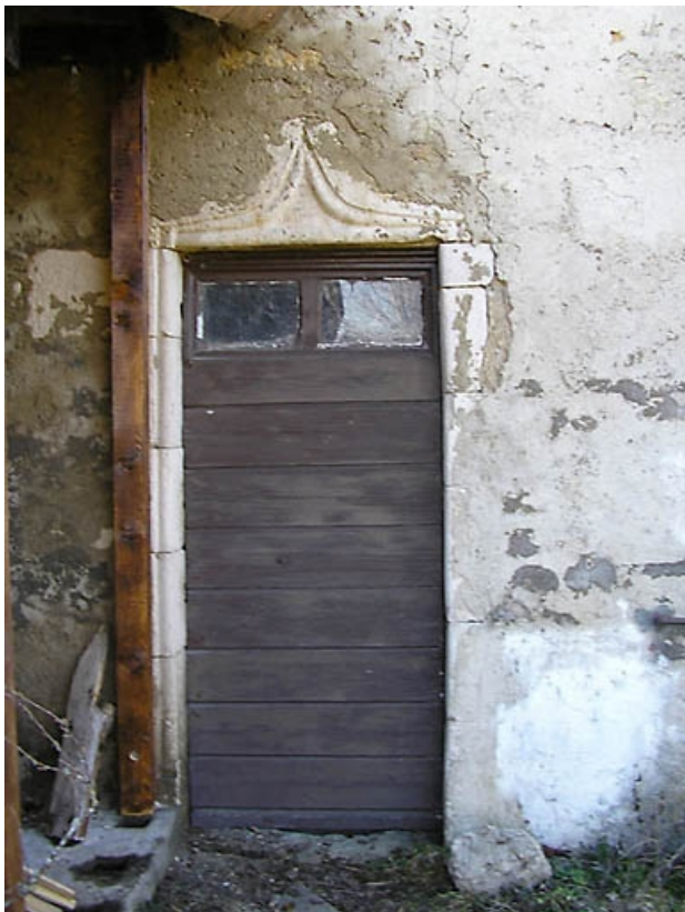
Vue de la porte avec linteau en accolade sur la façade postérieure.
