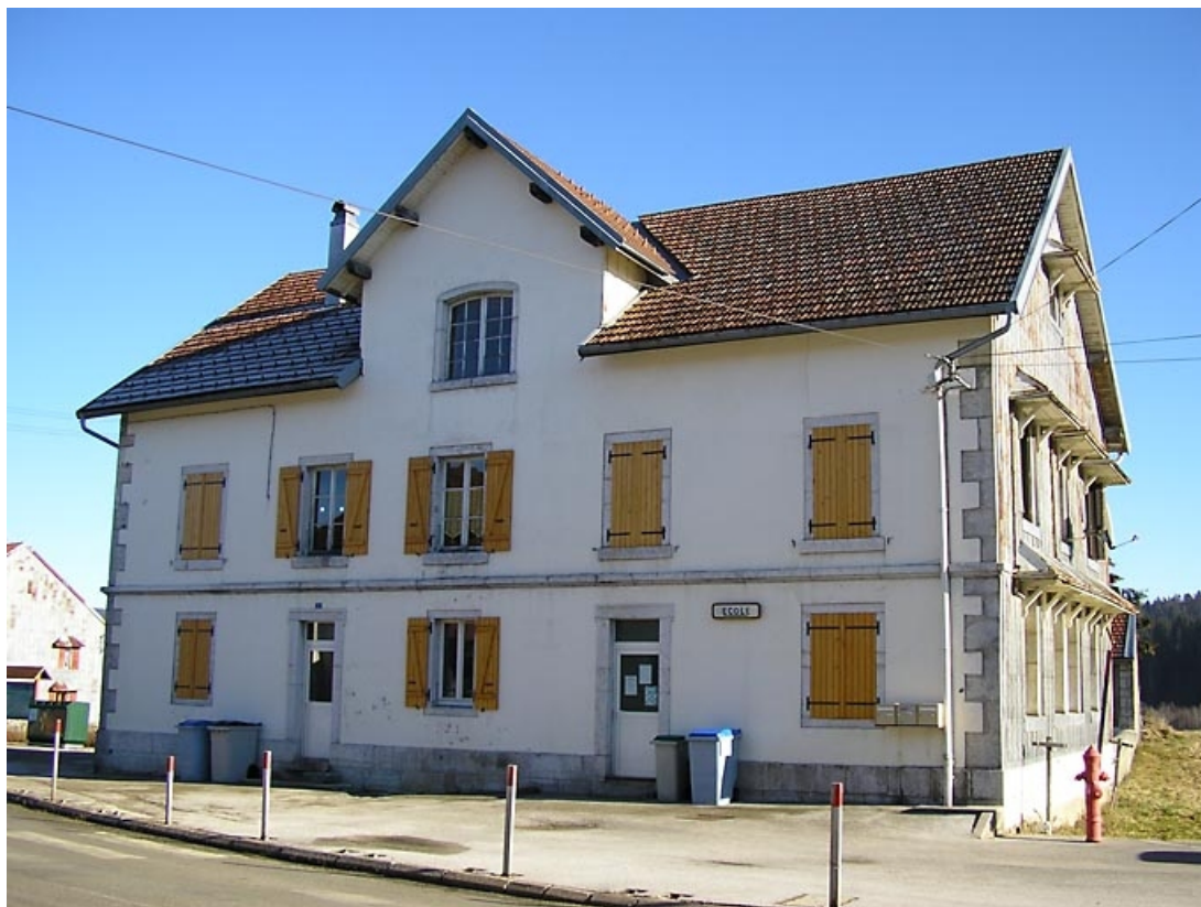
Façade antérieure et pignon sud-est vus de trois quarts.
