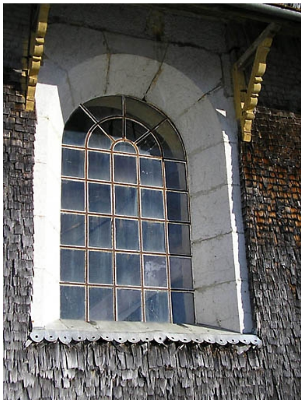
Vue d'une baie.
