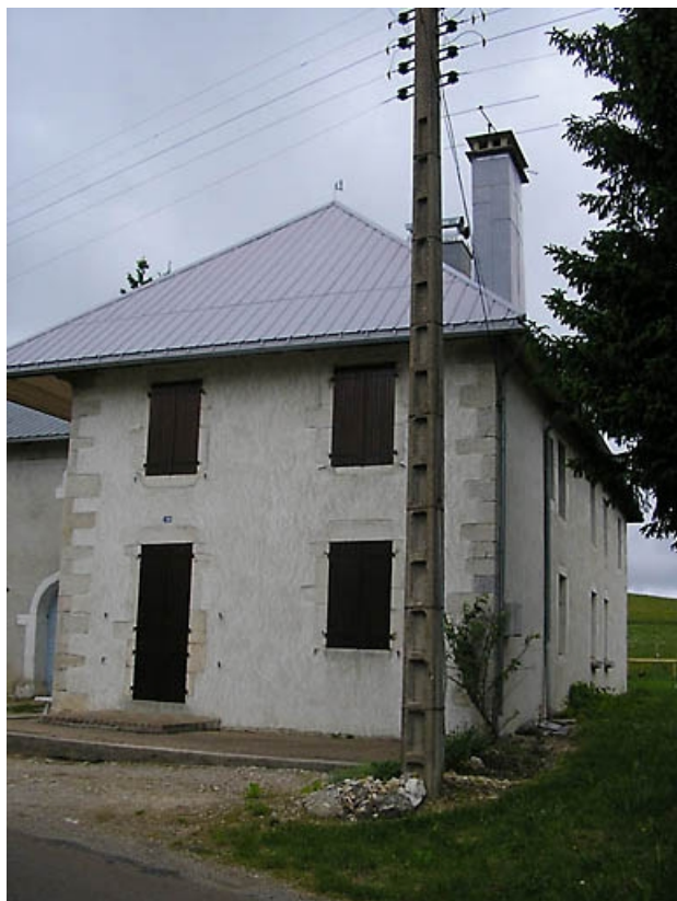
Pignon principal et façade latérale vus de trois quarts.
