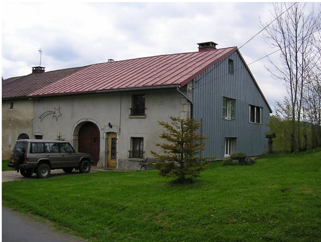
Façade antérieure et pignon nord-est vus de trois quarts. 39, Fort-du-Plasne, 175 les Voigneurs, lieudit : les Voigneurs
