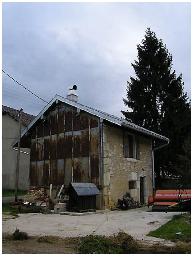
Pignon sud-ouest et façade antérieure vus de trois quarts.
