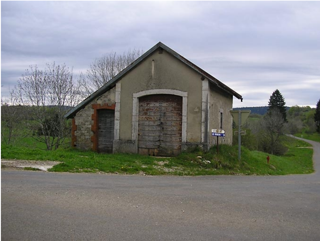
Façade antérieure et appentis.
