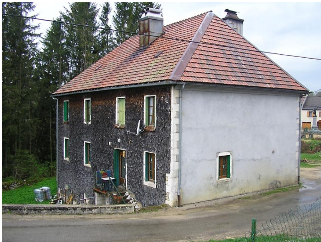
Façade postérieure sud vue de trois quarts.
