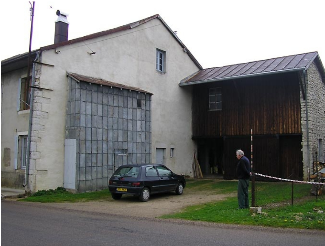
Pignon nord-est et remise vus de trois quarts.
