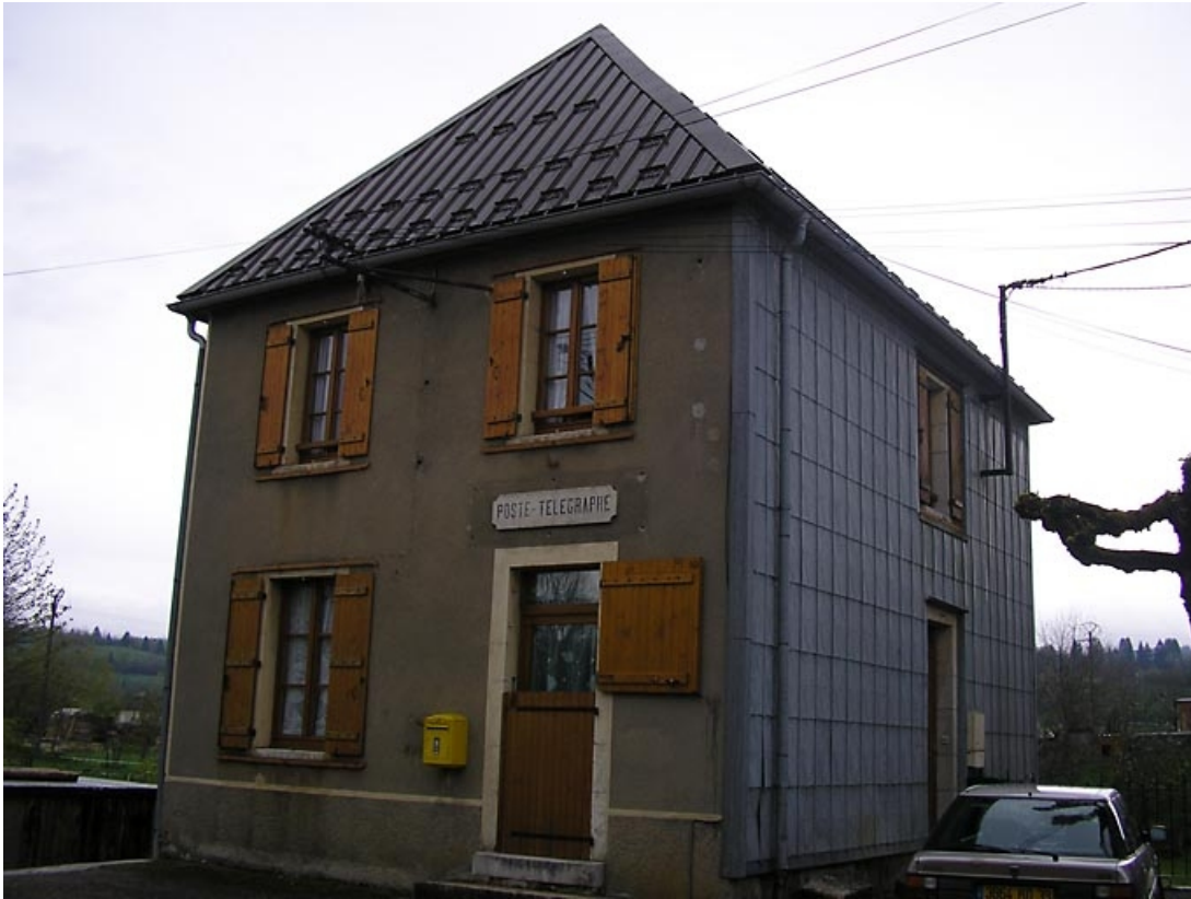
Façade antérieure et pignon sud-ouest vus de trois quarts. 39, Fort-du-Plasne
