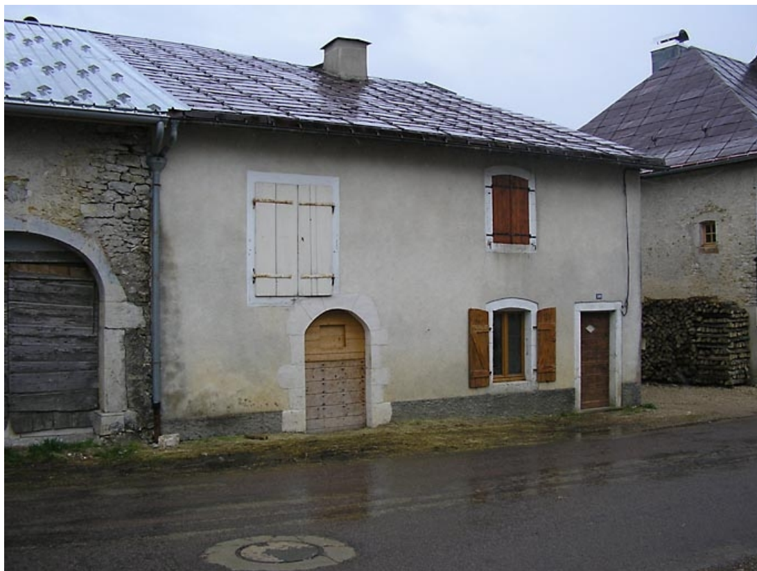
Façade antérieure vue de trois quarts.
