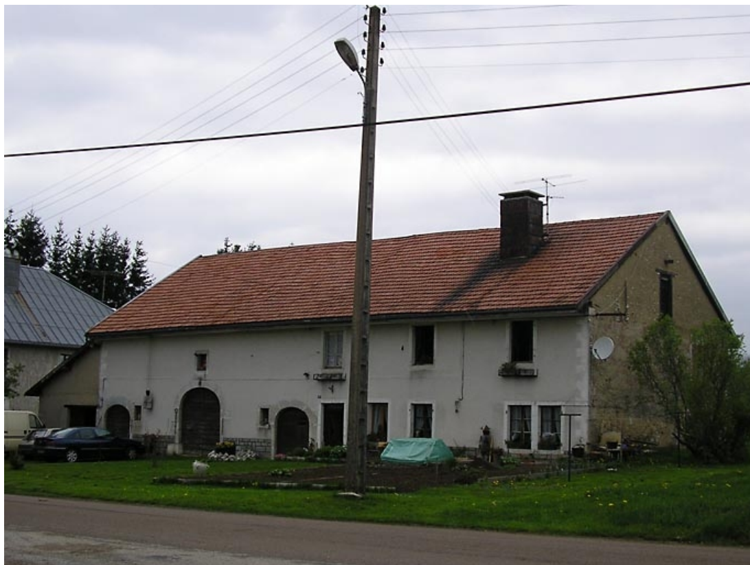
Façade antérieure et pignon nord-est vus de trois quarts.
