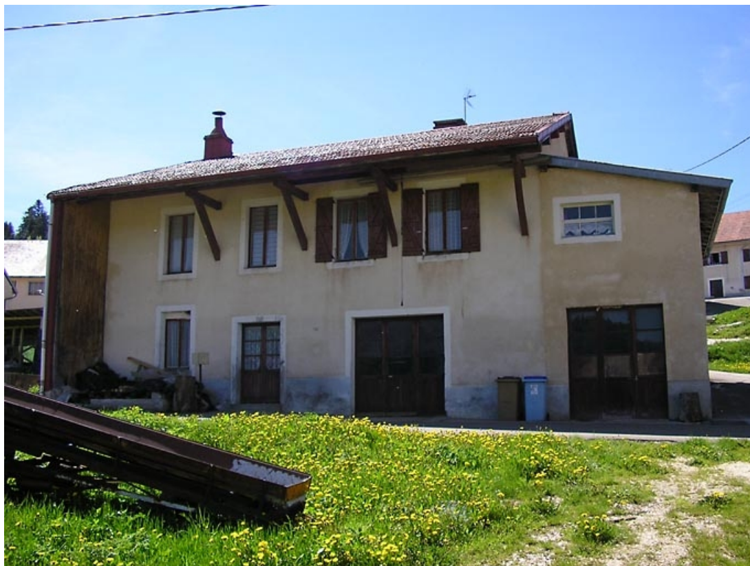
Vue latérale de la façade antérieure.
